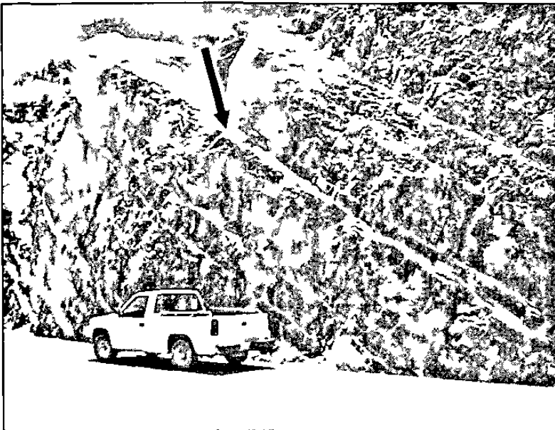
Fig. 3.18 Aspecto general del Talud #3. Se expone en esta fotografía, el mecanismo de falla correspondiente a cuña, de la cual aflora en forma notable la línea de intersección de los planos que delimitan dicho bloque, indicada en la gráfica por la flecha. Ubicación 29+360. Vista hacia el SE.
