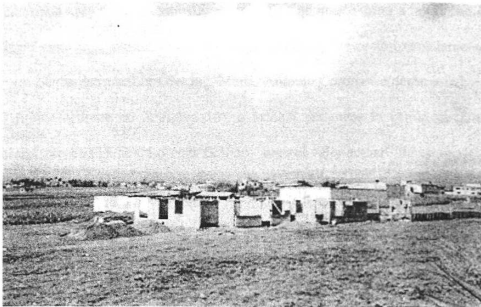
Figura 17. Levantado Completo de Paredes, aún sin Techo.
