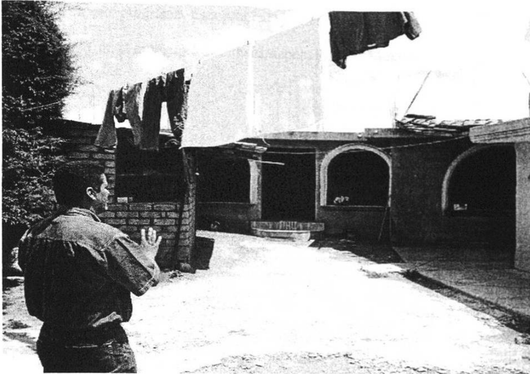
Figura 15. Proyecto al Fondo, en Etapa de Acabados, Dentro de una Vivienda Progresiva.
