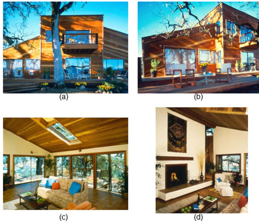
Figura 204.- David Wright, Prairie Sun, Cody, Wyoming, E.U.A, (1979): (a) Vista exterior – fachada posterior, (b) Vista exterior – fachada principal, (c) Sección transversal, (d) Perspectiva.
