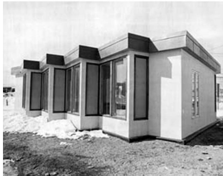
Figura 193.- MIT, Solar V, Massachusetts, E.U.A, (1978): Vista exterior.
