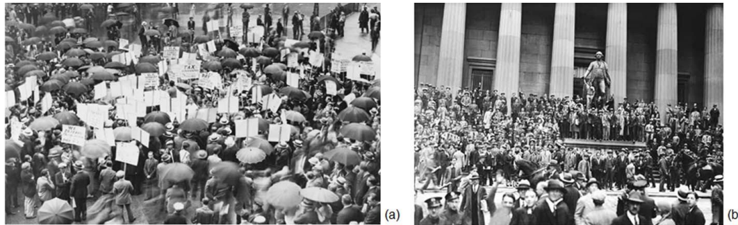
Figura 54.- (a) y (b) Ciudadanos esperan a las afueras de la bolsa en Wall Street, para retirar sus ahorros.
