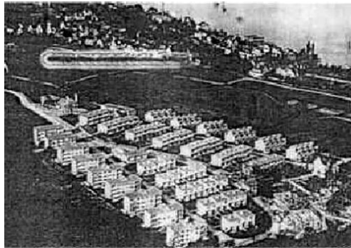
Figura 185.- El movimiento moderno descubrió el principio empleado en la antigua Grecia. Los edificios largos y estrechos se orientaban buscando el acceso al sol, lo cual se garantizaba, además, mediante la separación entre ellos. Max E. Haefeli, Carl Hubacher, Rudolf Steiger, Werner M. Moser, Emil Roth, Paul Artaria, Hans Schmidt, Colonia del Werkbund Neubühl, Zürich-Wollishofen, (1929-1932). Construcción de homigón prefabricado con muros portantes de ladrillo a modo de división entre paredes. 194 viviendas de 11 tipos (1-6 h): 89 apartamentos en bloques galería de tres plantas, 105 viviendas unifamiliares en hileras. Cooperativa de la asociación Neubühl.
