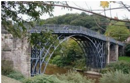
Figura 14.- Puente construido por Abraham Darby en Coalbrookdale, Shropshire, el primer puente de hierro en el mundo. Tomado de un grabado publicado en 1806.
