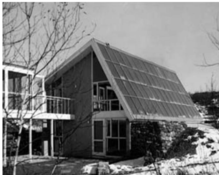
Figura 192.- MIT, Solar IV, Massachusetts, E.U.A, (1959): Vista exterior.
