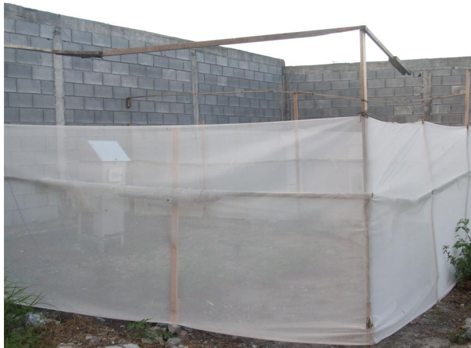
Imagen 5. Colocación de la tela para impedir la transferencia de PST.
