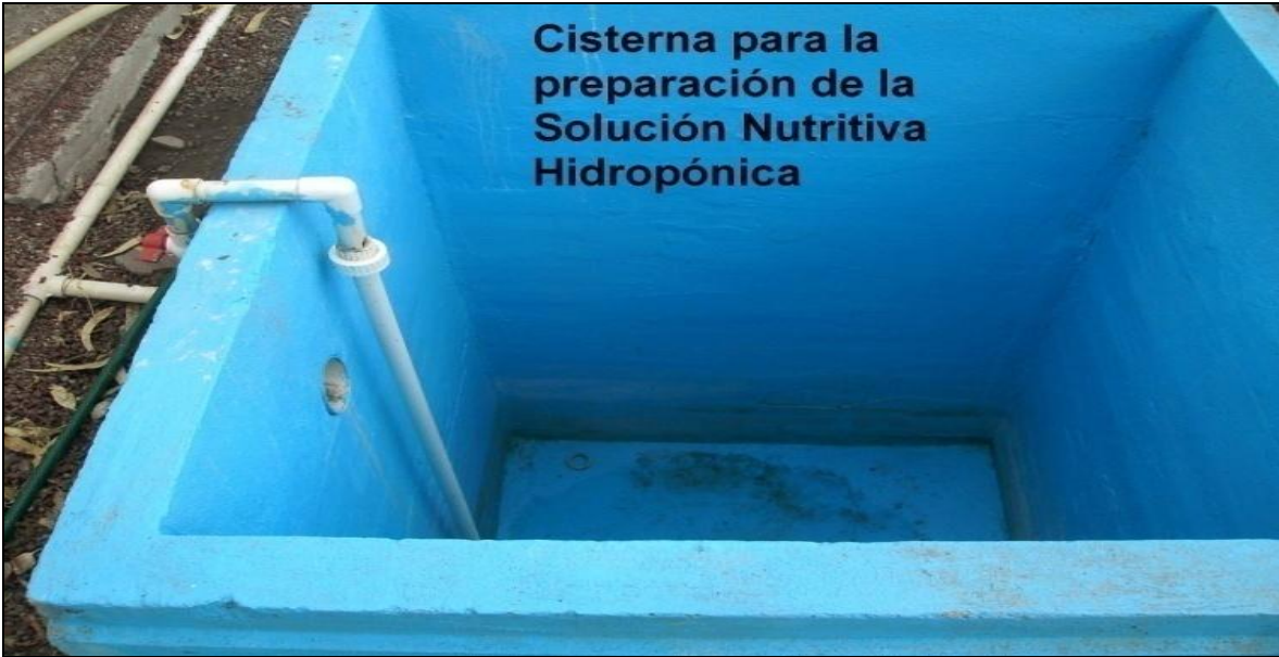
Fotografía 2. Cisterna para preparar la SNH con un volumen de 2.5 m 3 .
