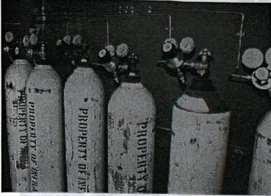
Fot. S5 Cuarto de Tanques de Gas
