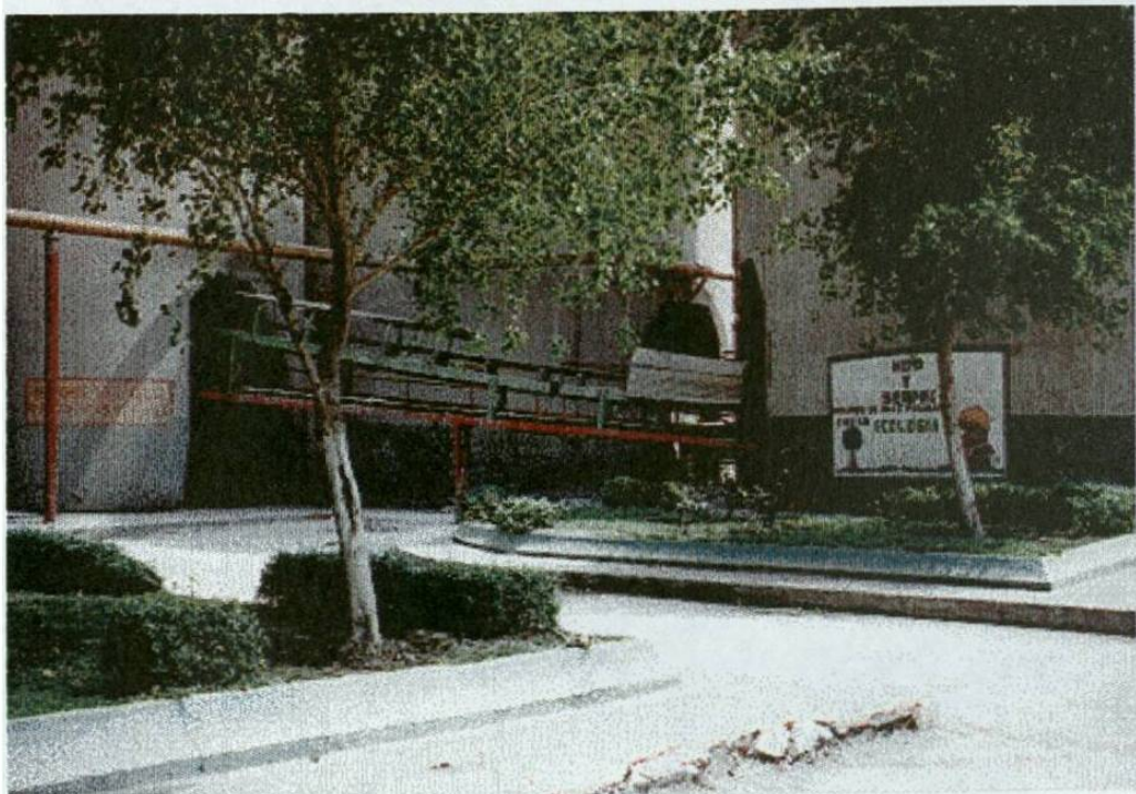
Foto 3-4 Vista de la banda transportadora de descarga del silo de caliza desde la parte exterior del edificio de molinos de materia prima lado sur después de implementar las 5S+1
