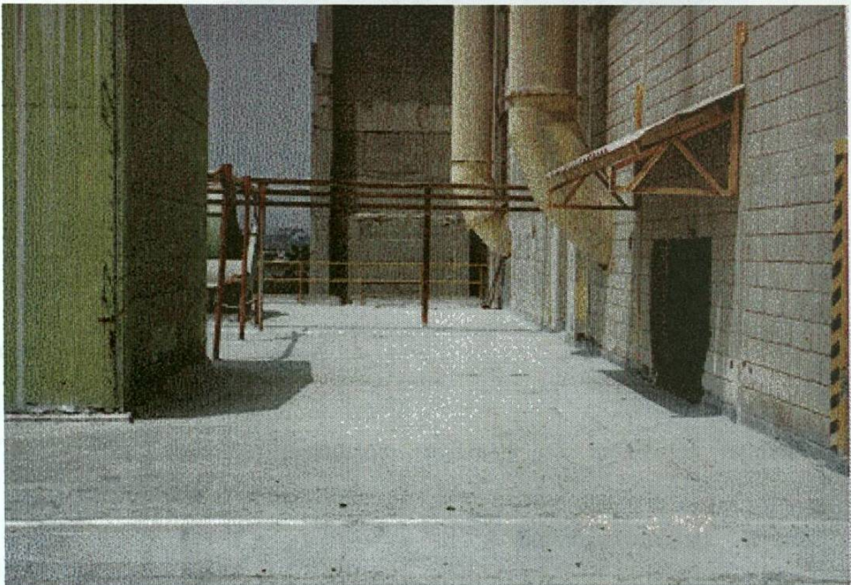
Foto 3-8 Vista del acceso sur a colectores de molinos de materia prima 7 y 8 después de implementar las 5S+1
