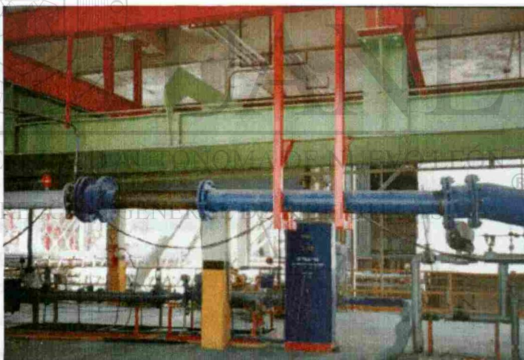
**Foto 3-12 Vista del área de la plataforma del Horno N° 10 donde se muestra la tubería de alimentación de coque de petróleo al quemador principal después de implementar los pasos 1 y 2 del Mantenimiento Autónomo.**
