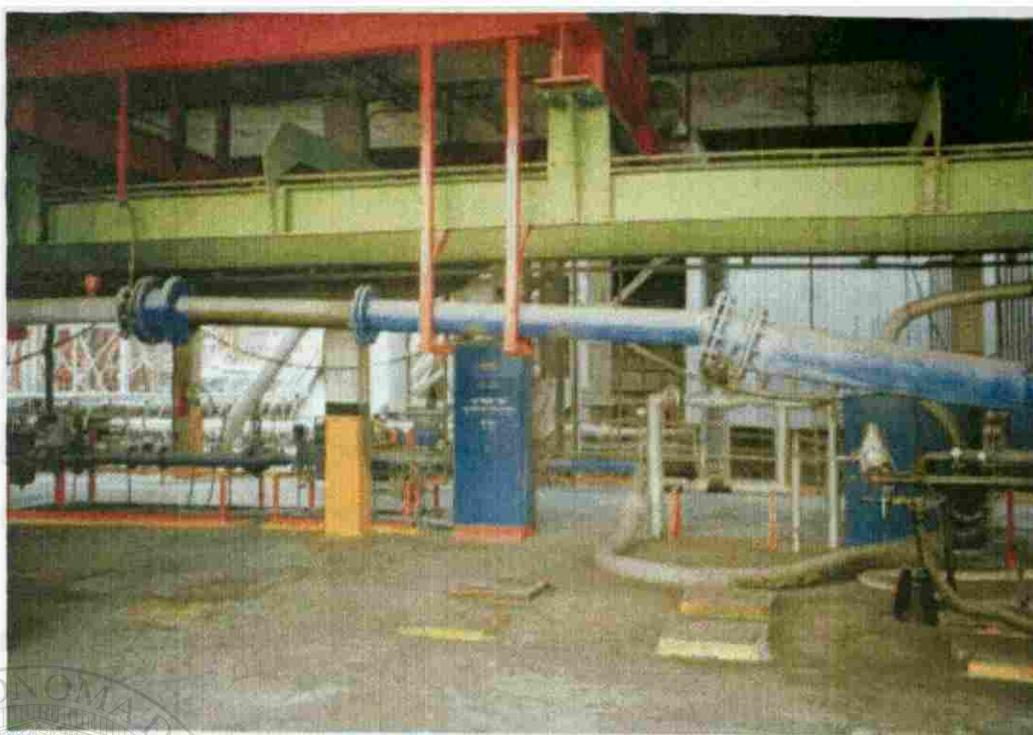
**Foto 3-11 Vista del área de la plataforma del Horno N° 10 donde se muestra la tubería de alimentación de coque de petróleo al quemador principal antes de implementar el Mantenimiento Autónomo**
