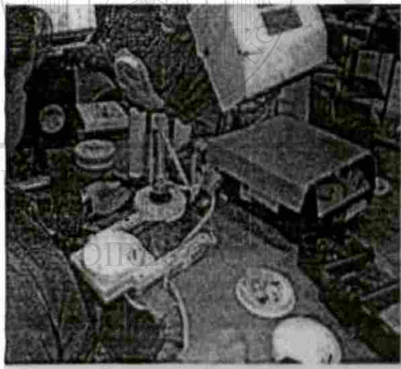
Operación de cierre de unidad AC/DC
