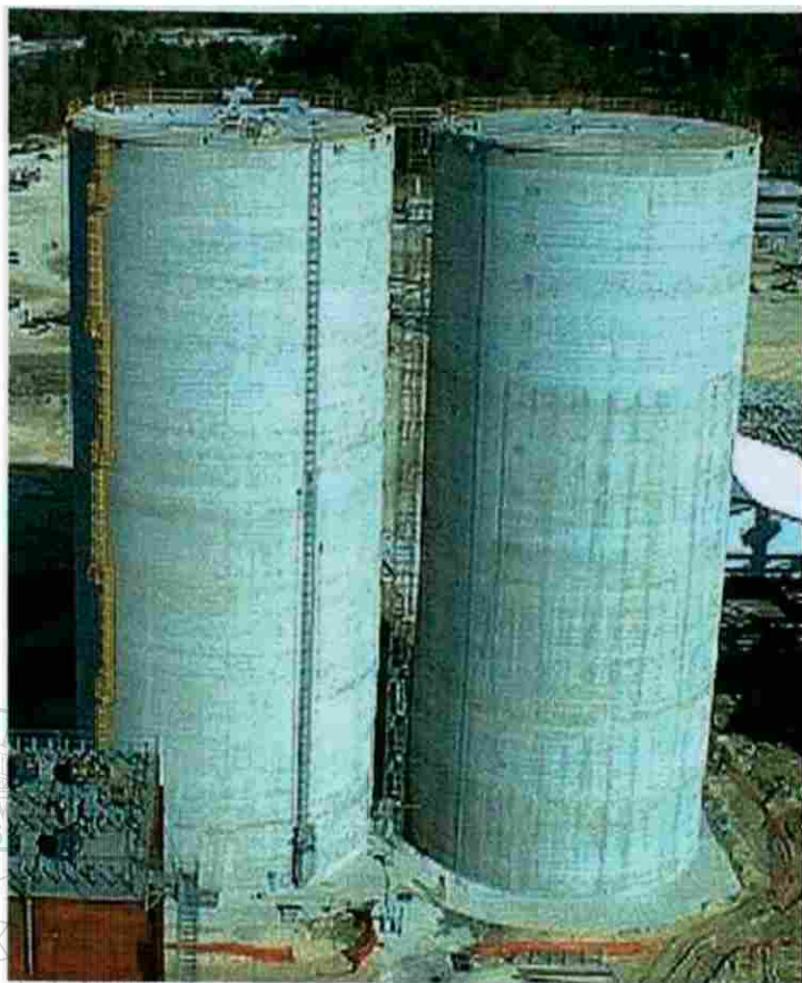
Fotografía 3-7. Silos gemelos de concreto post-tensado, para almacenamiento de clinker.
