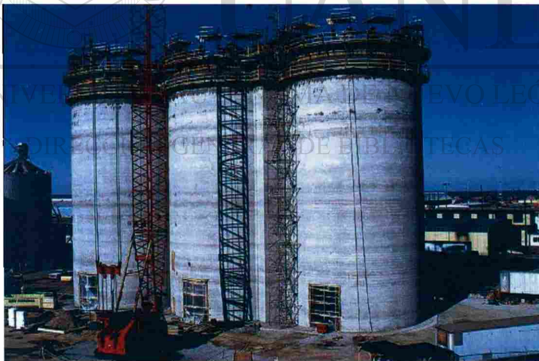
Fotografía 3-6. Silos de concreto reforzado, para almacenamiento de cemento, en etapa de construcción.
