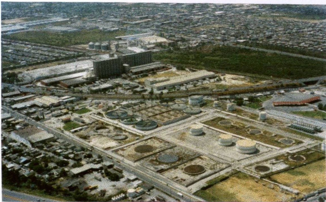
Arriba: Tiraderos de desechos en predios de Escobedo, N.L. Abajo: Instalaciones de PEMEX San Rafael, Guadalupe, N.L.; Fugas al subsuelo con posible contaminación de los acuíferos freáticos.
