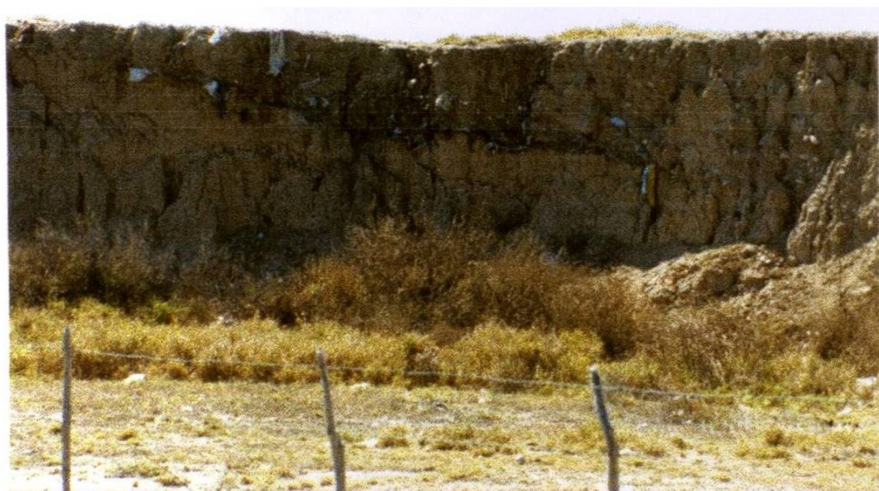
Antiguo relleno sanitario en Salinas Victoria, N.L.
