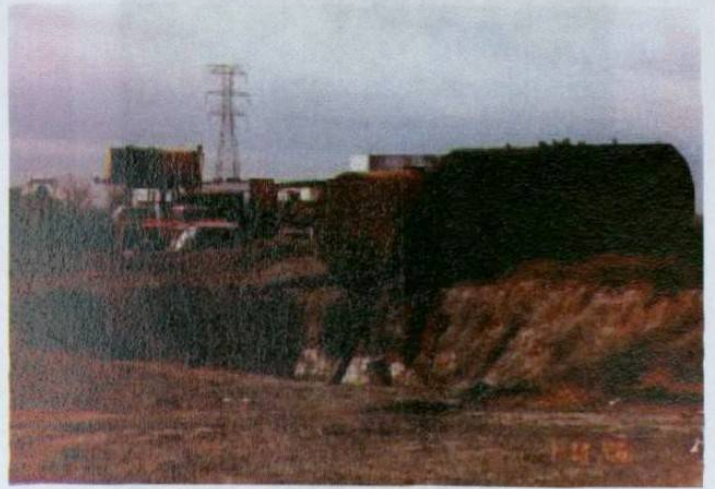
TANQUES DE DIESEL
