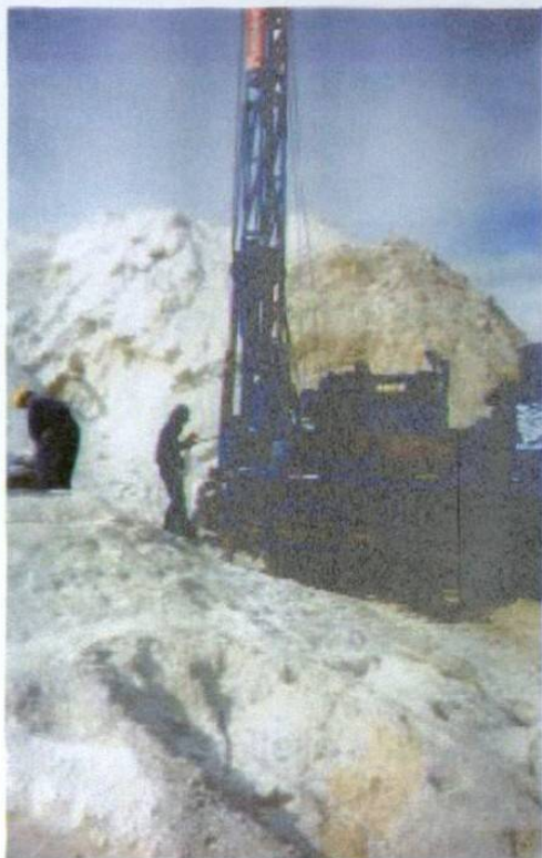
PERFORACIÓN EN EL MONTÍCULO DE ANHIDRITA
