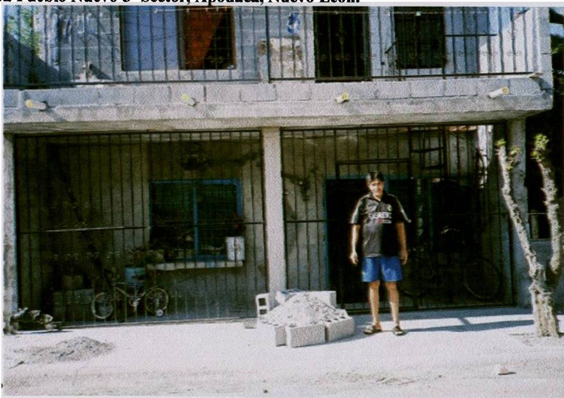
27) Río Santiago 819 (VIVIENDA SIN ACABADOS, EN EL EXTERIOR CON ZARPEO Y AFINE) Col. Pueblo Nuevo 5° Sector, Apodaca, Nuevo León.
