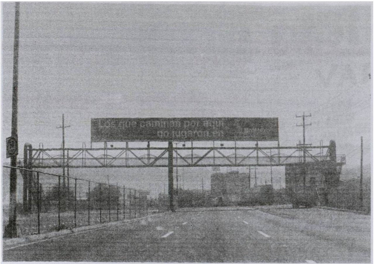
Leyenda en puente peatonal frente a colonia Fernando Amilpa
