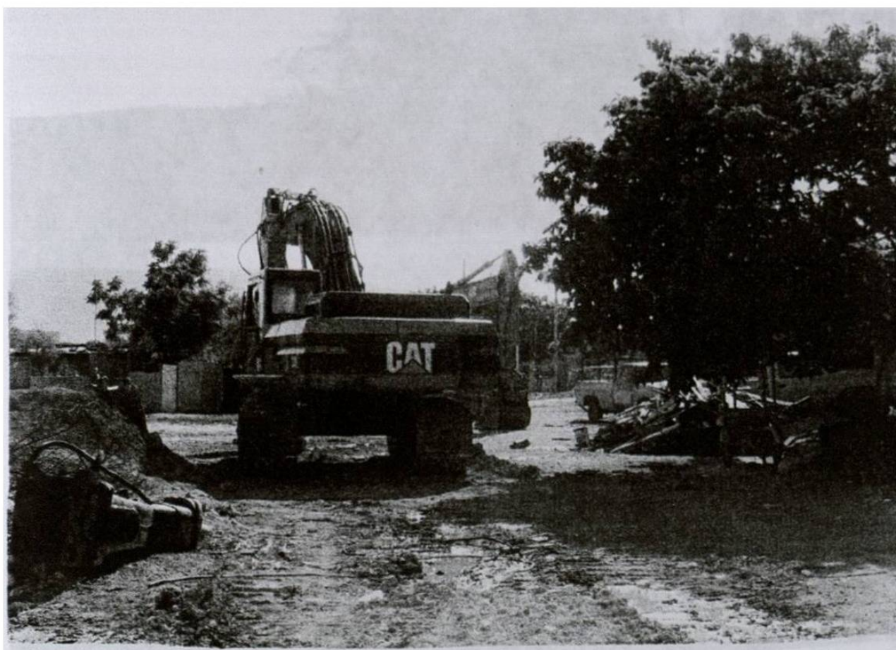
Obras de excavación para introducción del servicio de drenaje
