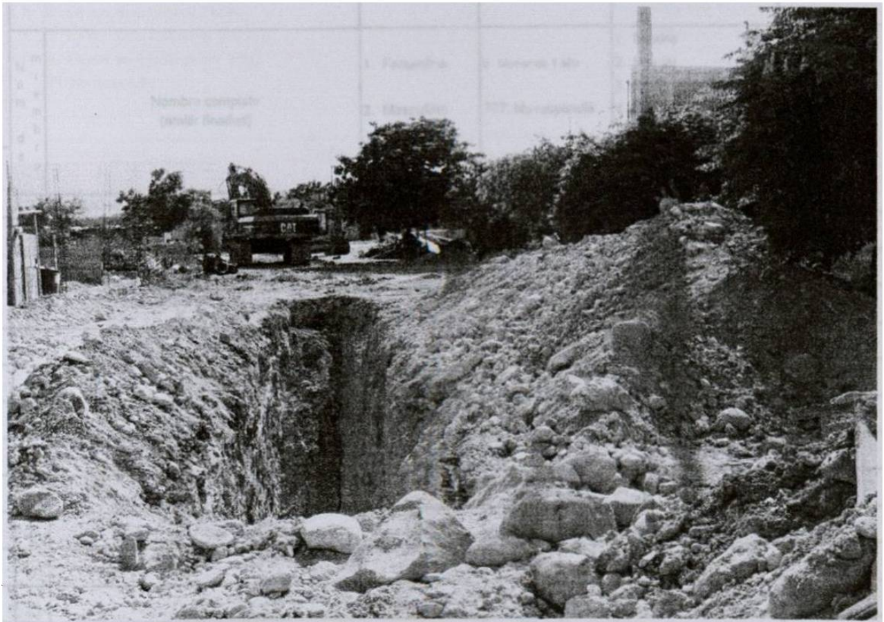
F12. Obras para la conexión del drenaje
