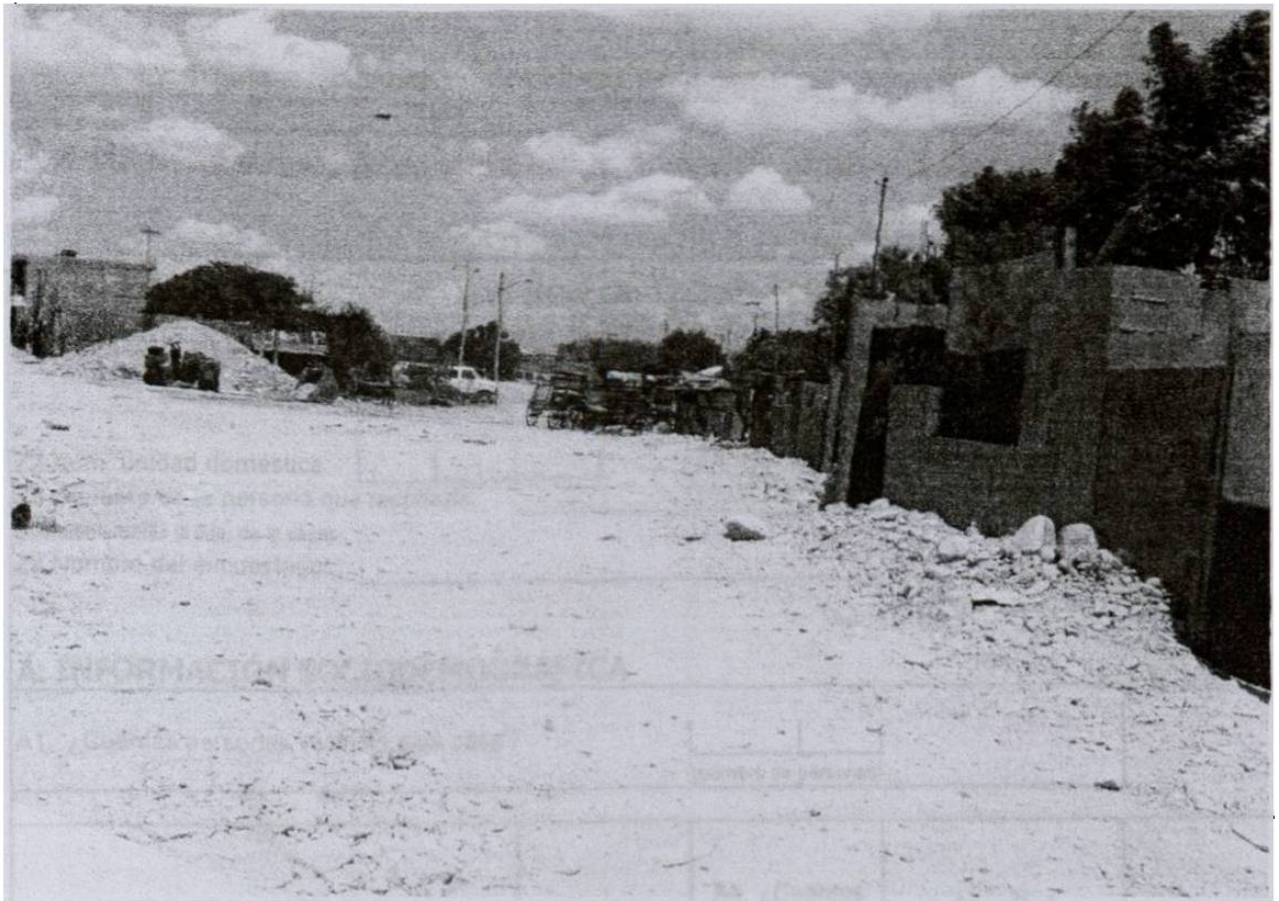
F11. Calle Fco. I. Madero
