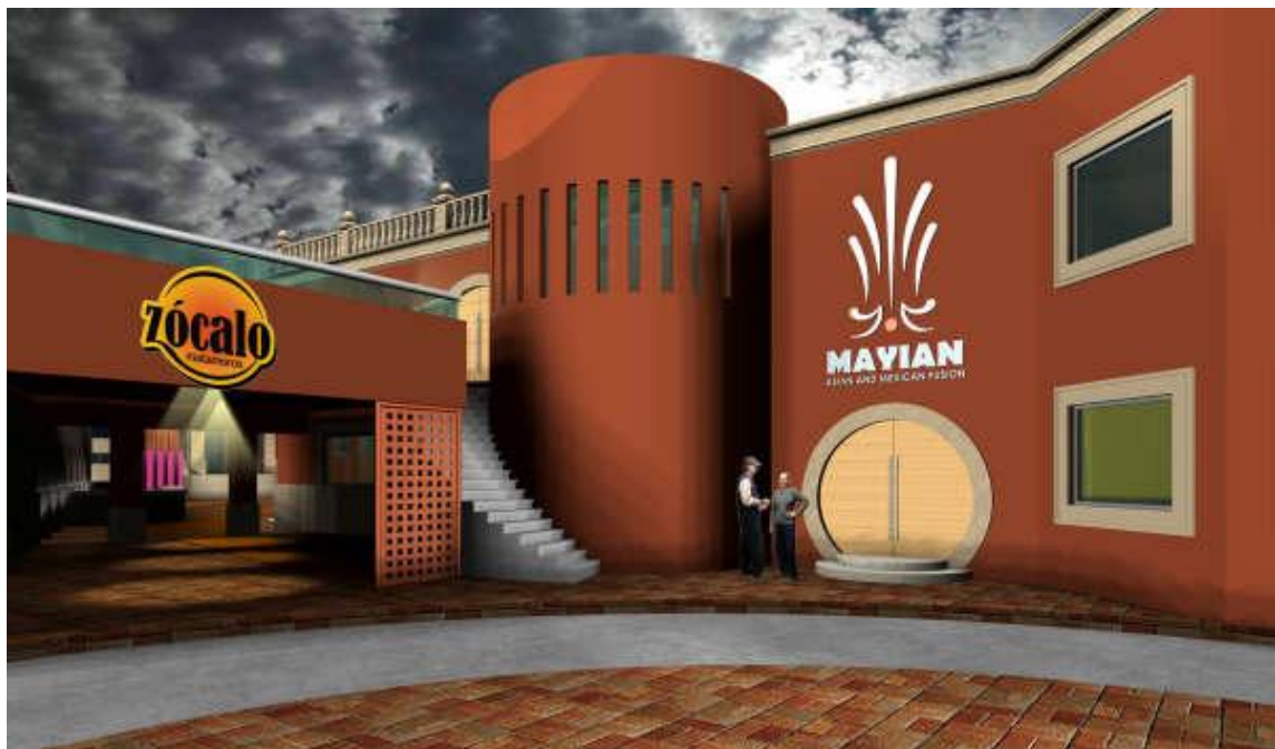
Imagen 1.10 Proyecto Centro Comercial en el sector de la zona dorada, con obra negra terminada, Matamoros, Tamaulipas.)
