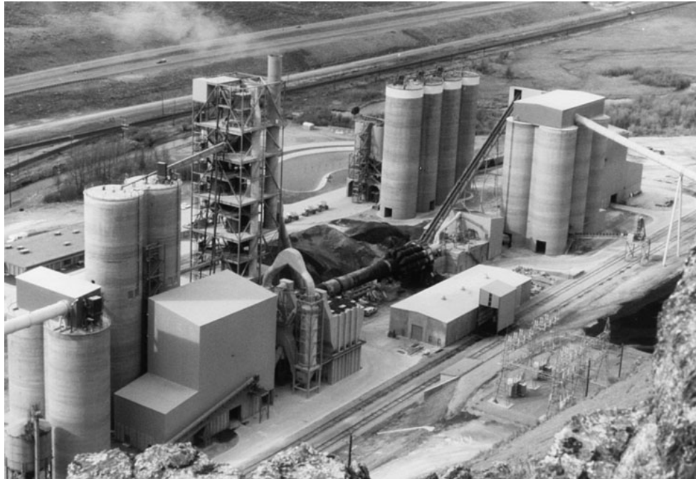
Figura 4. Vista aérea de una planta cementera (Mehta et al, 2004).
