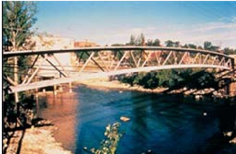
Figura 7. Puente peatonal en Sherbrooke, Quebec.
