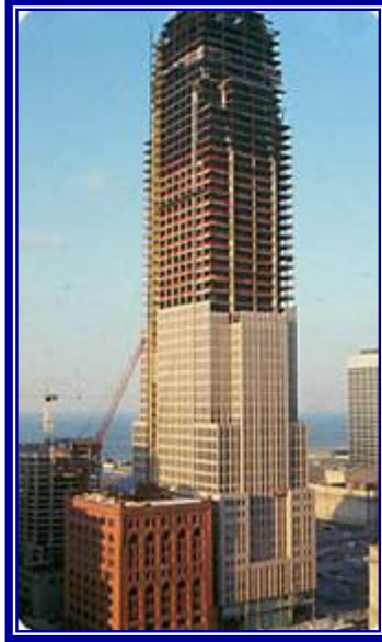
Figura 2.10. Humo de sílice se utiliza en concretos de alta resistencia, para dar rigidez. Torre en Cleveland, Ohio.
