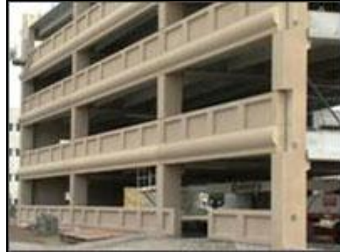
Figura 10. Elemento de la figura 9 colocado. 8
