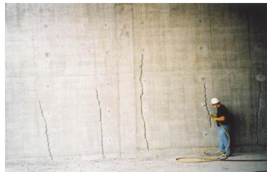
Figura 19. Reparación de grietas por retracción en muro. 11
