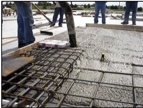
Figura 7. Colado con SCC (a). 6
