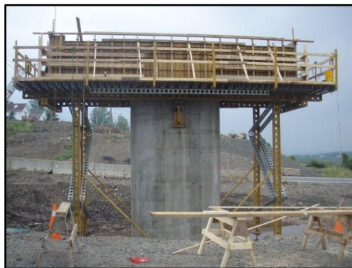
Figura 5. Pila de concreto con cimbra lista para el colado del cabezal. 4
