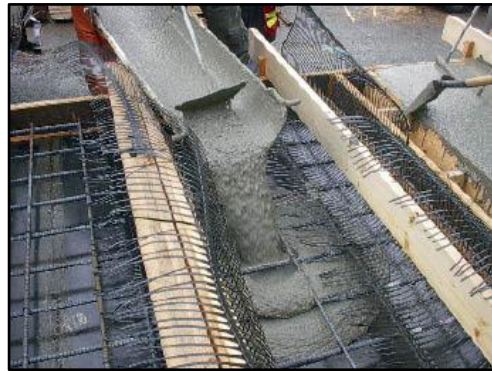
Figura 8. Colado de SCC (b). 7
