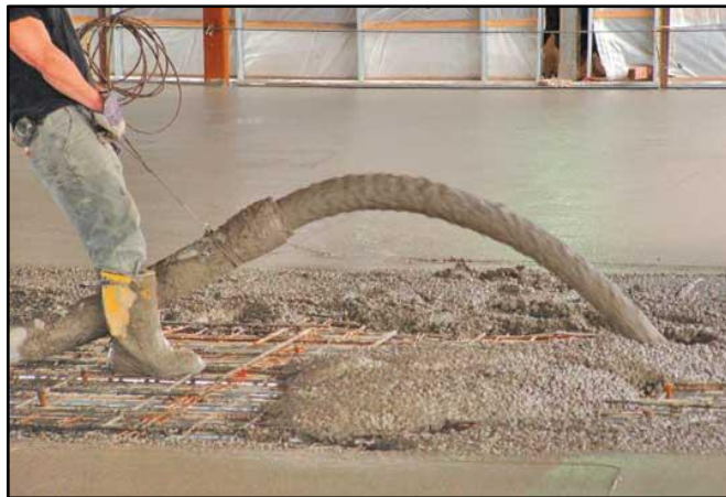
Figura 11. Colado de entrepiso con concreto ligero. 9
