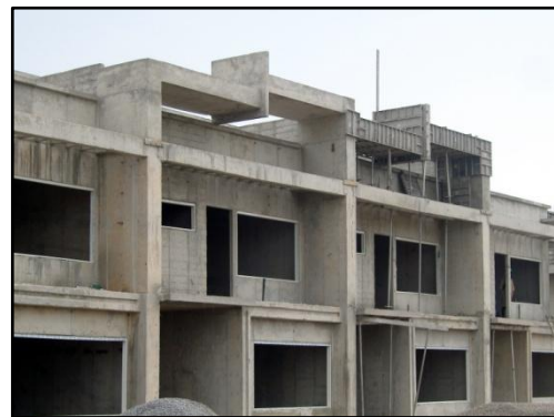
Figura 6. Edificio de concreto en construcción. 5
