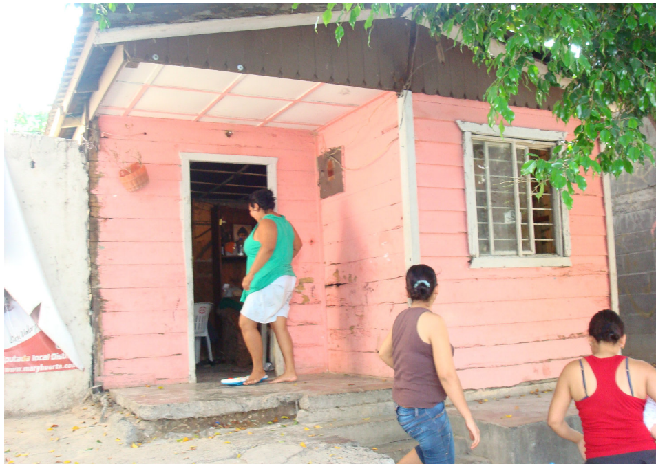
Imagen 16. Adaptación a la orografía del terreno (Ubicado en Lago de Pátzcuaro acera sur entre Guanajuato y Zacatecas)
