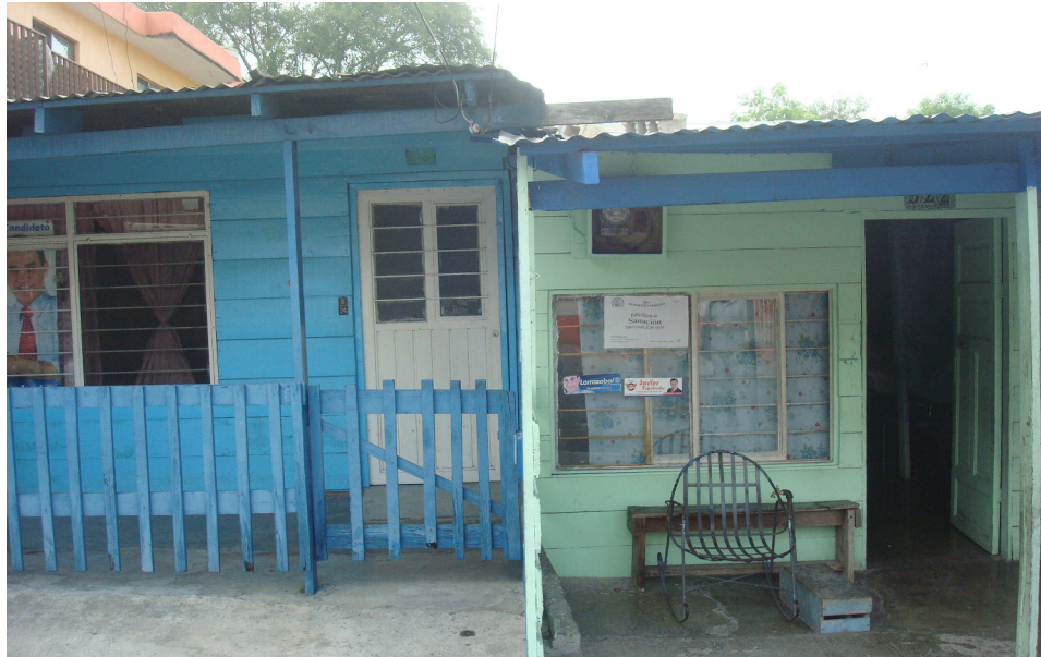
Imagen 15. Varios tejabanos de un mismo diseñador (Ubicado en la acera poniente de la calle Querétaro entre Nva. Independencia y Tepeyac)
