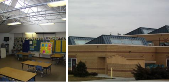
Fig. 47: Interior y exterior de la escuela Fort Collins school con vanos de clerestorios orientados al sur
