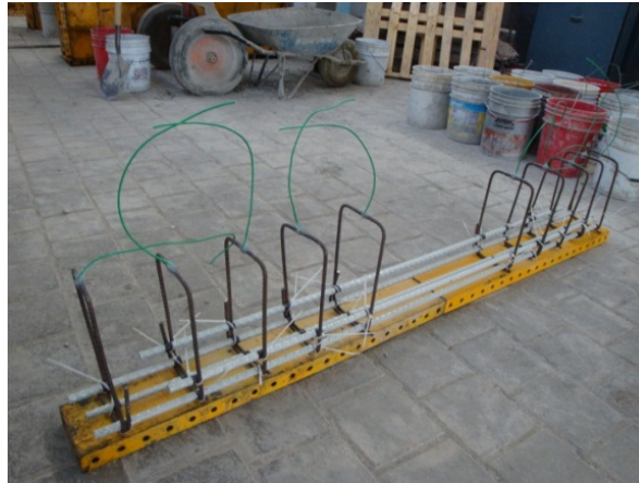
Figura 22. Arreglo del acero de refuerzo previo al colado.
