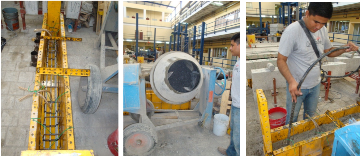
Figura 23. Cimbra para la fabricación (a), Arreglo final para el colado (b), Fabricación del concreto (c) y Vibrado del concreto
