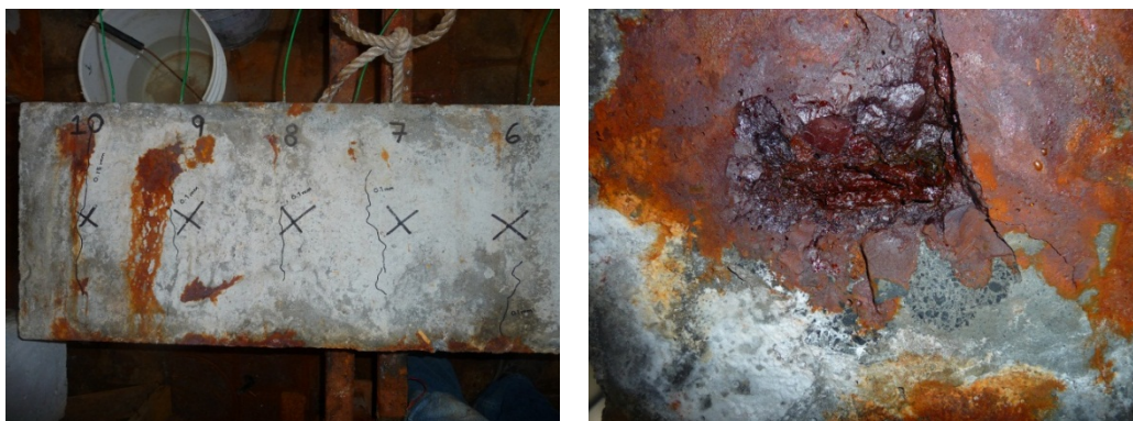
Figura 28. Inspección visual de las vigas.
