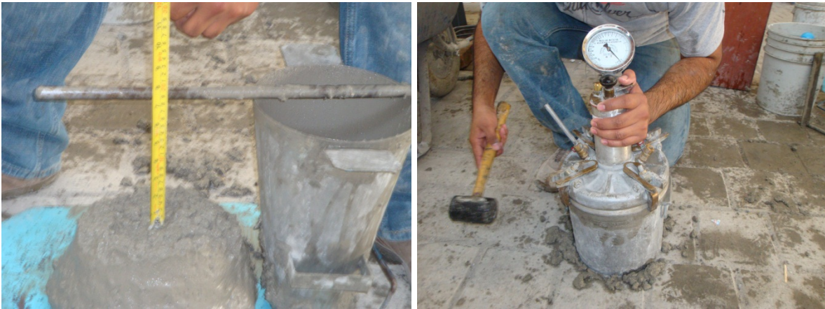
Figura 16. Pruebas al concreto fresco, a) Revenimiento y b) Contenido de aire.
