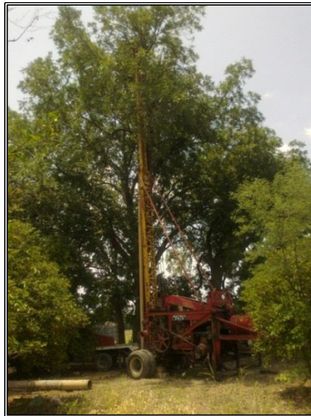
Fotografía 6.1.- Máquina de percusión utilizada para la perforación del pozo.
