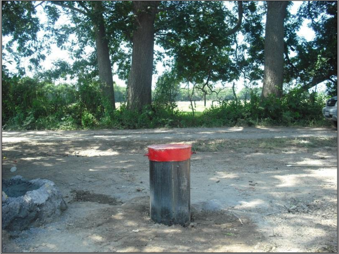
Fotografía 6.3.- Pozo recién perforado, listo para efectuar la prueba de aforo, para después culminar con el diseño final, conforme a la Norma NOM-003 CNA-1996.
