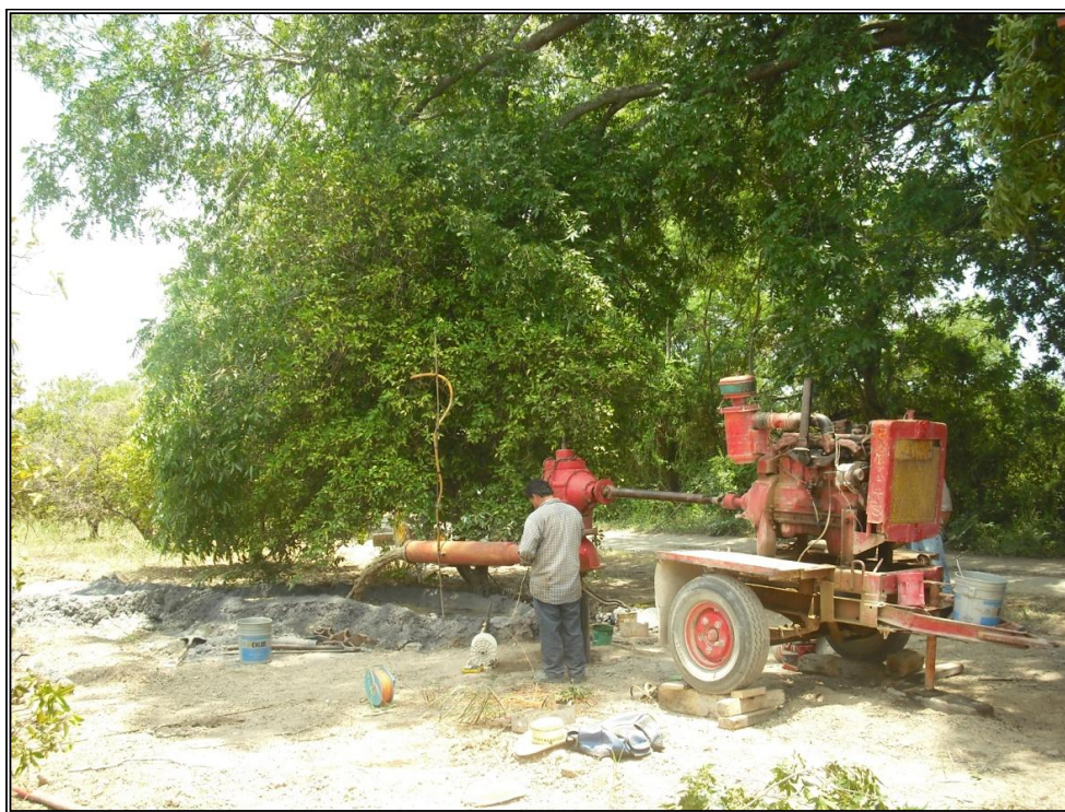
Fotografía 6.4.- Prueba de aforo del pozo perforado.
