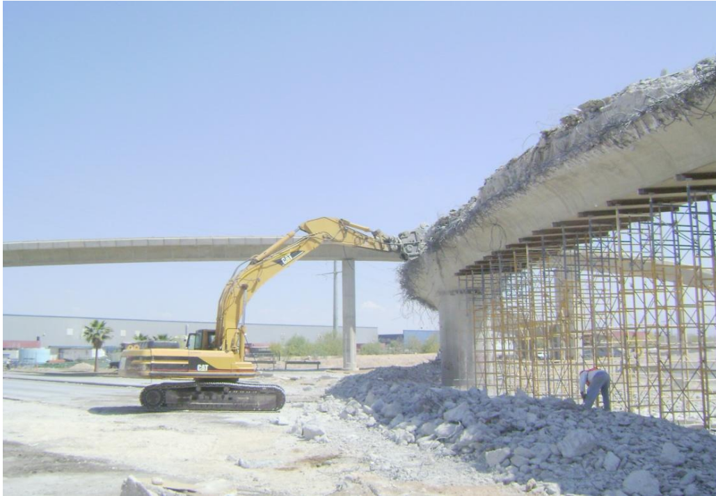
Figura 57 Demolición de ala exterior del tramo central de menor claro.
