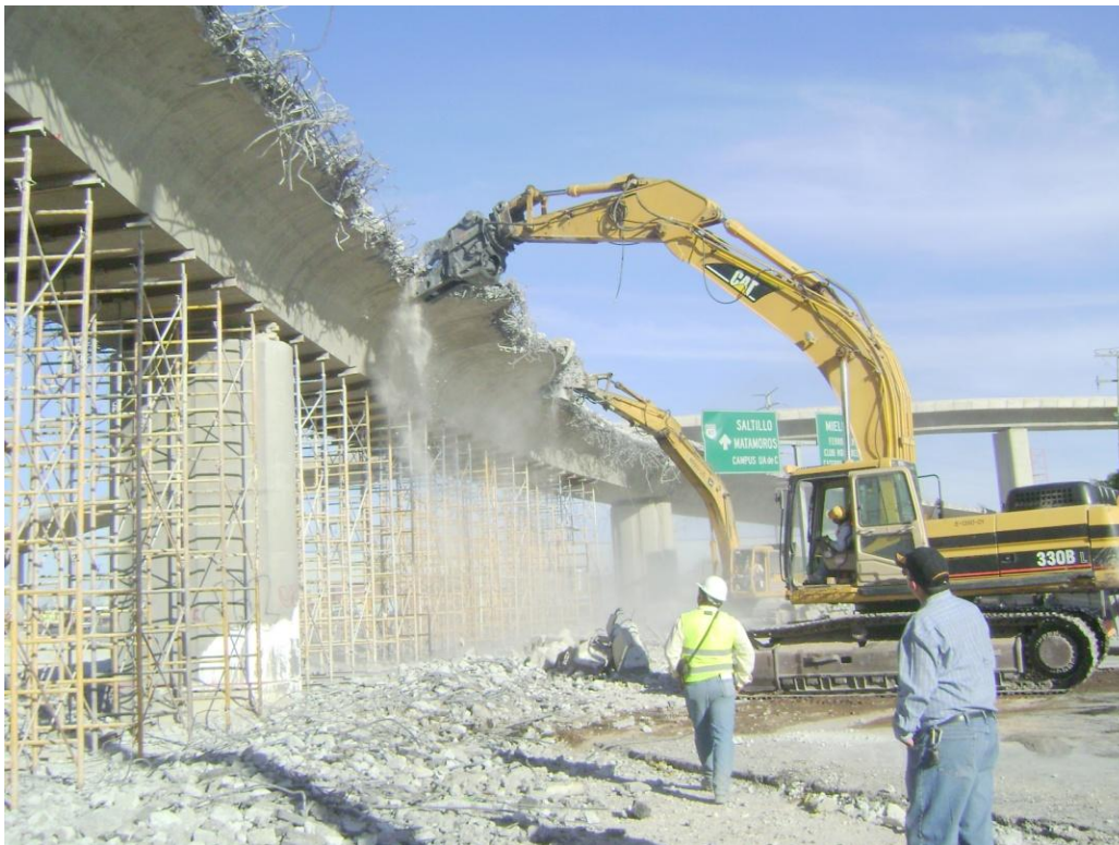
Figura 56 Demolición de ala interior del tramo central de mayor claro.
