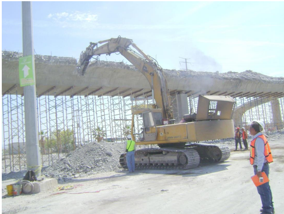
Figura 62 Demolición de ala interior del tramo secundario de menor claro.
