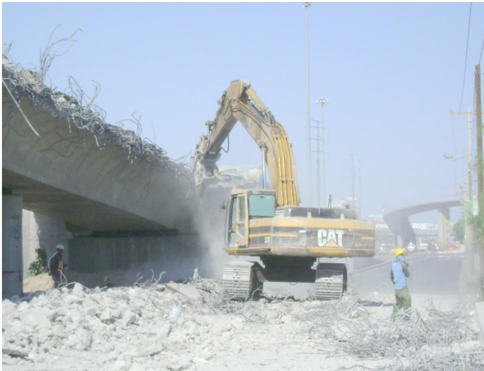
Figura 68 Demolición de ala interior del tramo de estribo norte.
