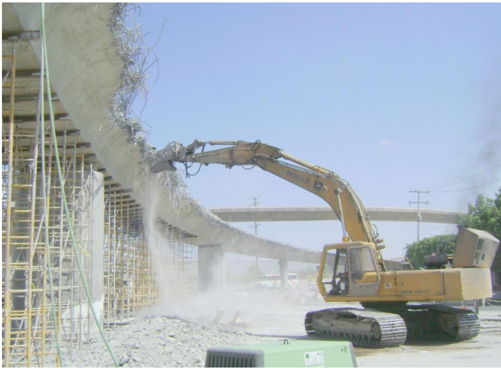
Figura 58 Demolición de ala interior del tramo central de menor claro.
