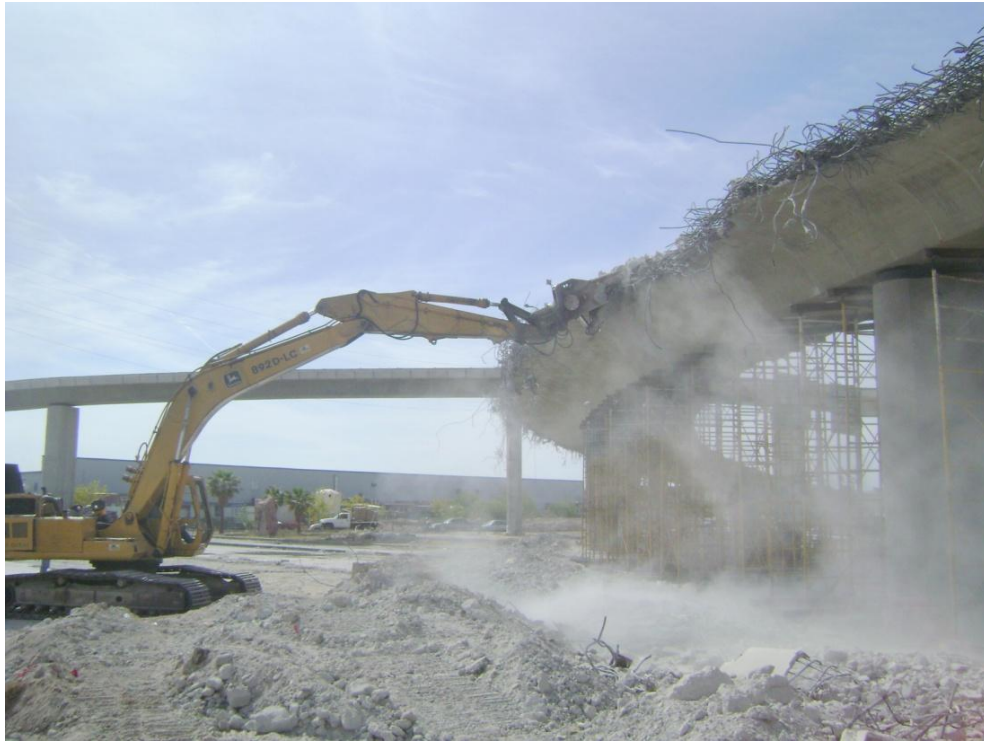
Figura 59 Demolición de ala exterior del tramo secundario de mayor claro.
