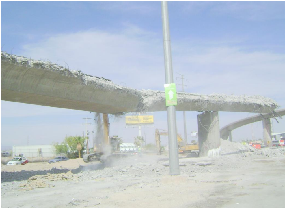
Figura 73 Demolición y corte de ambas secciones laterales del viaducto central de menor claro.
