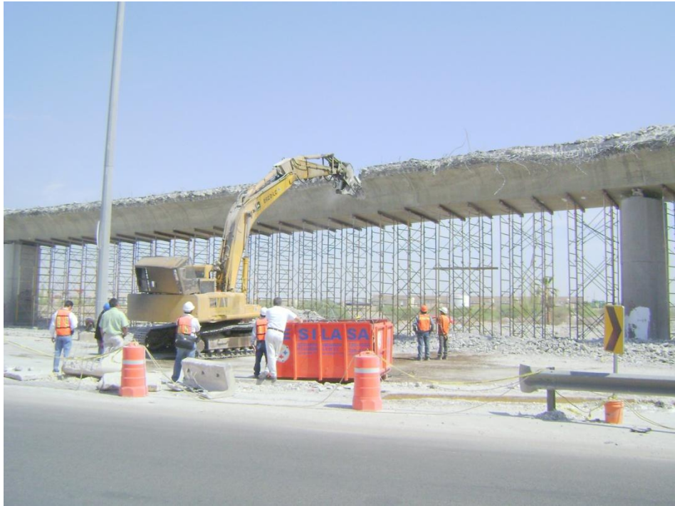
Figura 61 Demolición de ala exterior del tramo secundario de menor claro.
