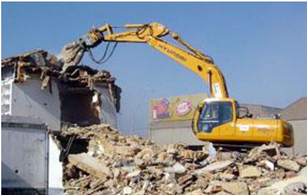
Figura 4 Operación de maquina en demolición.
