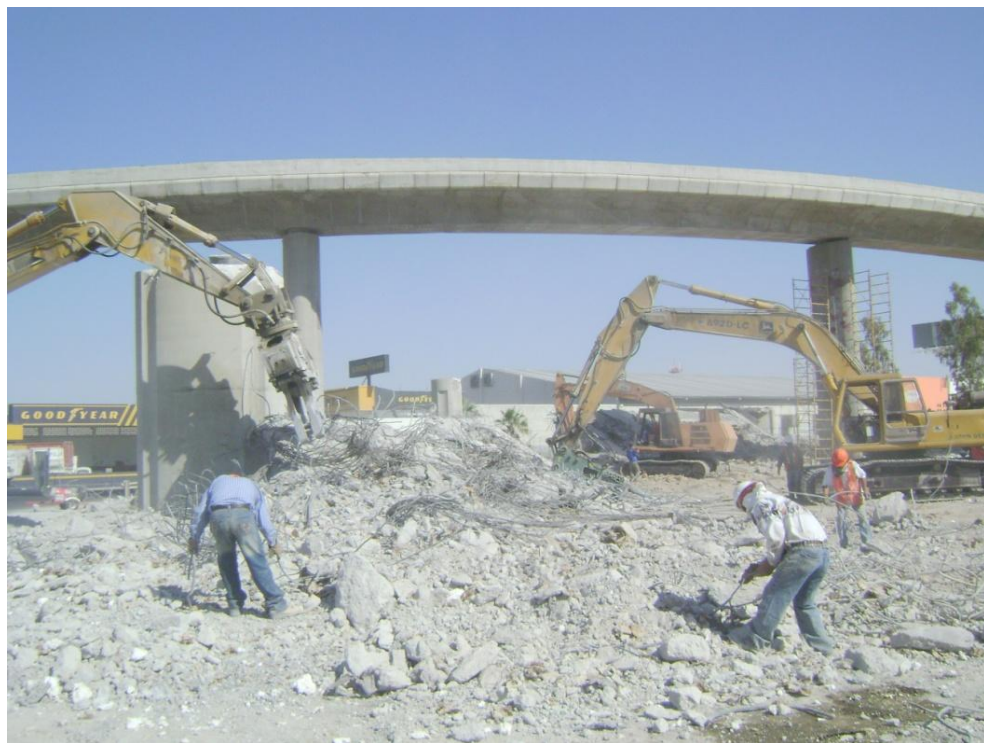
Figura 86 Demolición de viaductos y columnas con martillo.
