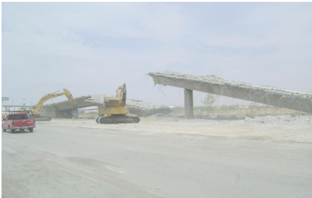
Figura 78 Corte y demolición total del viaducto secundario de menor claro.
