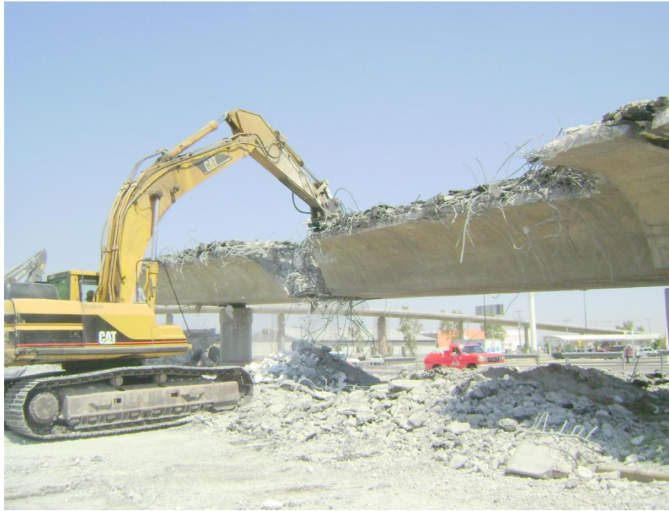
Figura 83 Demolición y corte de ambas secciones laterales del viaducto de estribo norte.
