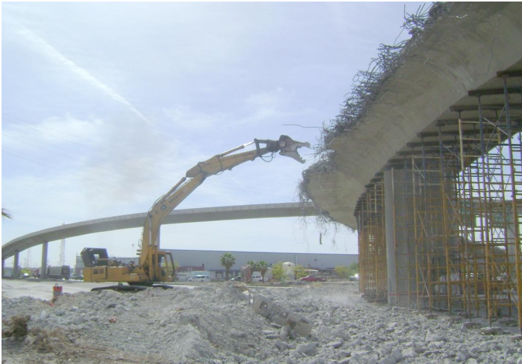
Figura 55 Demolición de ala exterior del tramo central de mayor claro.
