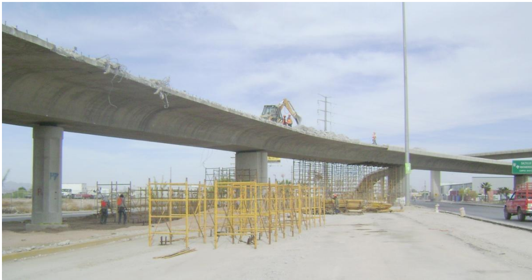
Figura 51 Etapa de trazo y referencia de trayectoria del presfuerzo para atapas de demolición.
