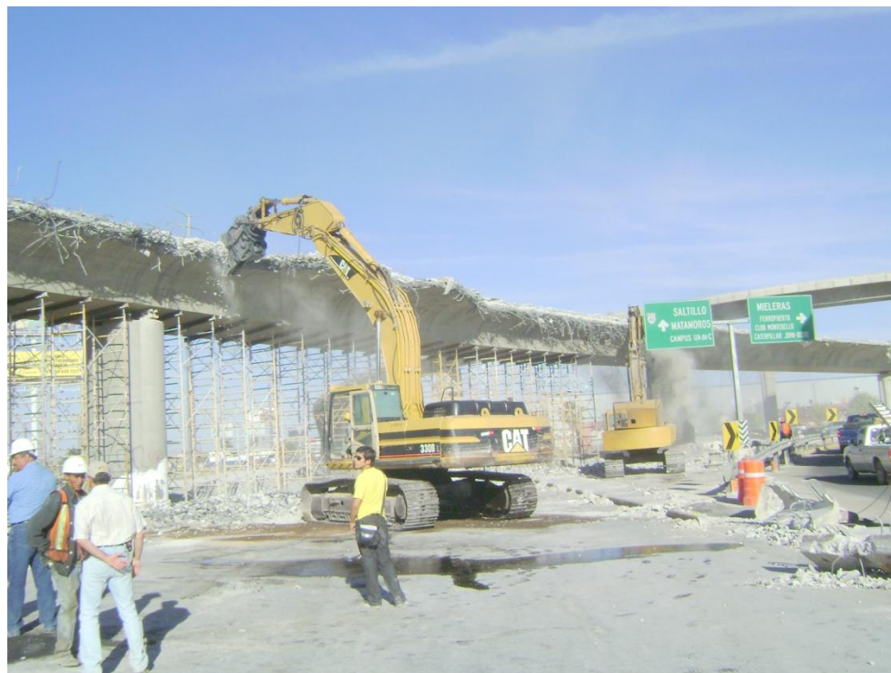
Figura 60 Demolición de ala interior del tramo secundario de mayor claro.
