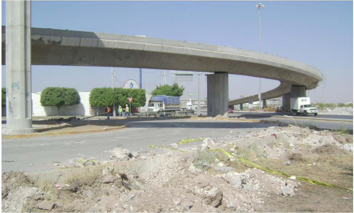
Figura 43 Vista panorámica de puente vehicular a demoler.
