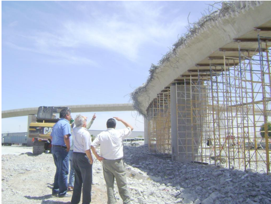
Figura 63 Demolición de ala exterior del tramo terciario.
