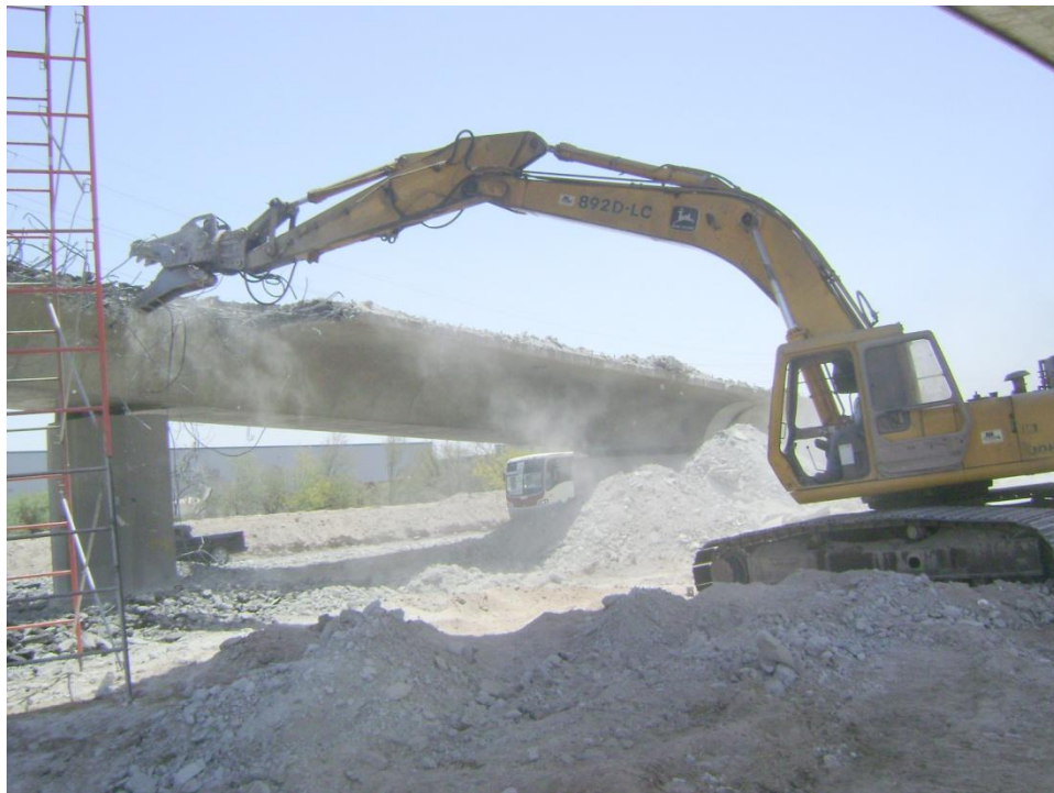
Figura 66 Demolición de ala interior del tramo de estribo sur.
