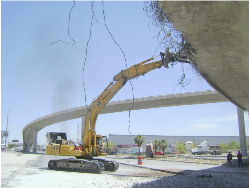
Figura 53 Demolición de ala exterior del viaducto central primario (Disminución de área en volado).
