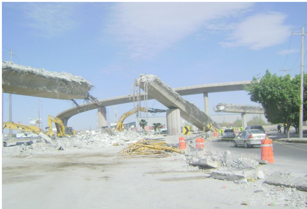
Figura 74 Corte y demolición total del viaducto central de menor claro.
