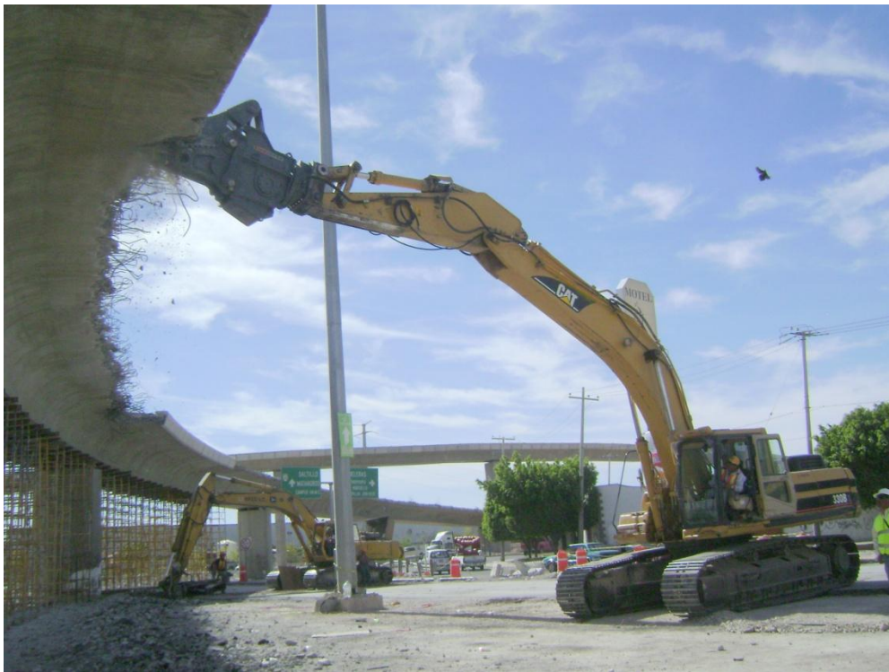
Figura 54 Demolición de ala interior del viaducto central primario (Disminución de área en volado).
