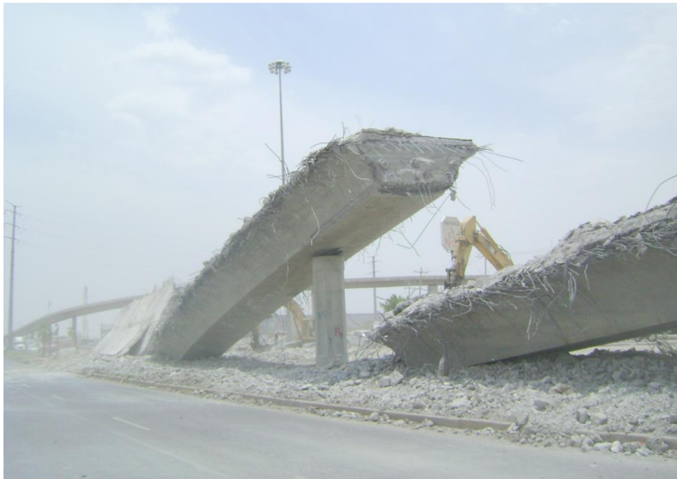
Figura 84 Corte y demolición total del viaducto de estribo norte.
