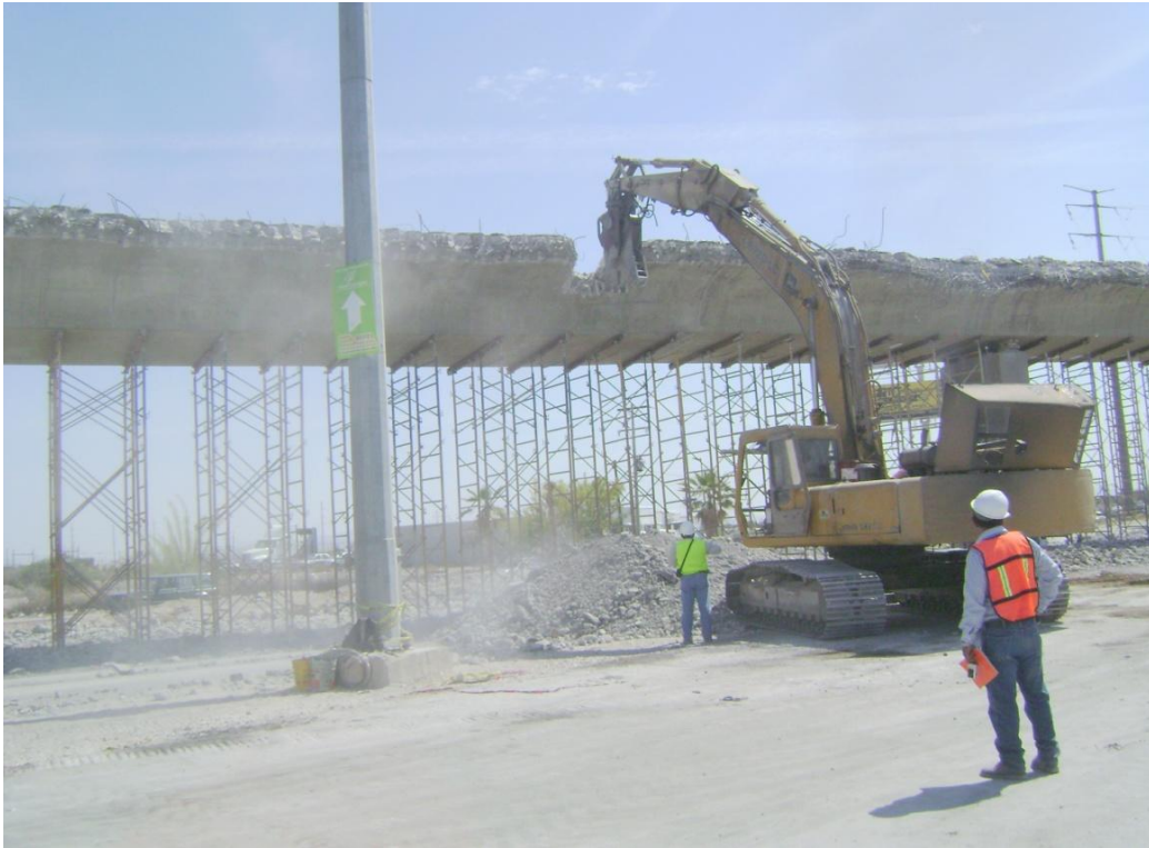
Figura 71 Demolición y corte de ambas secciones laterales del viaducto central de mayor claro.
