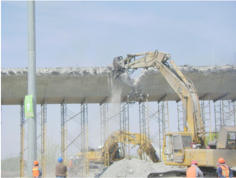
Figura 77 Demolición y corte de ambas secciones laterales del viaducto secundario de menor claro.
