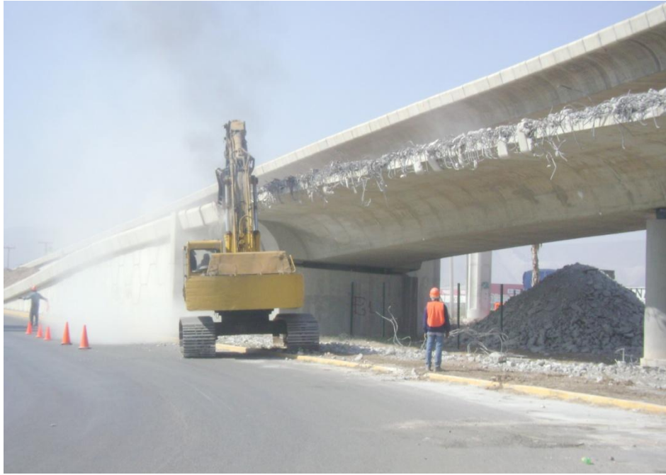
Figura 65 Demolición de ala exterior del tramo de estribo sur.
