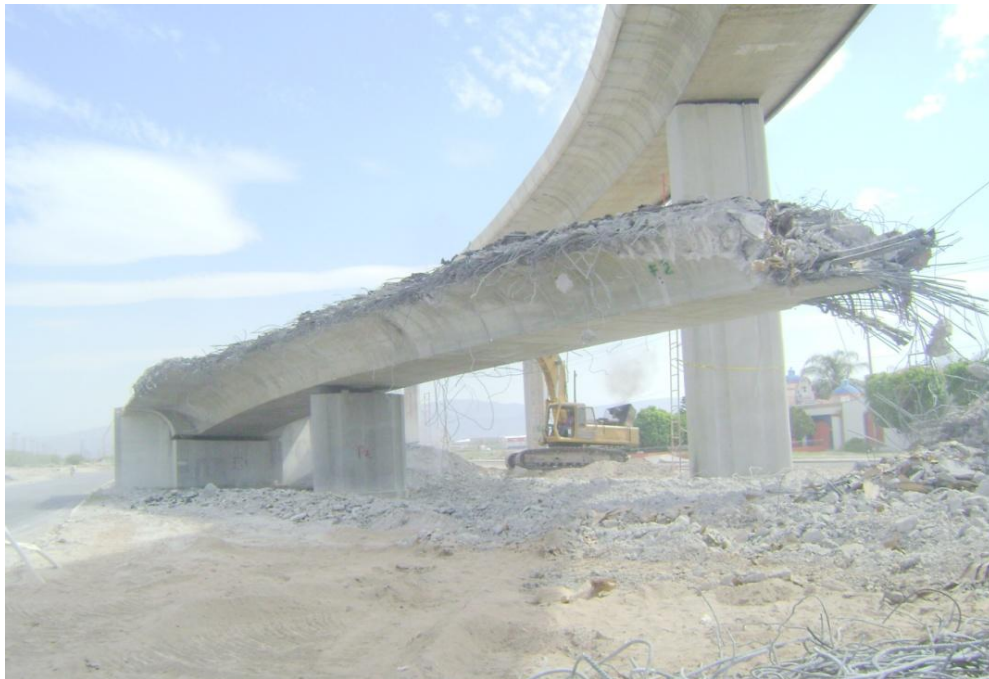
Figura 80 Corte y demolición total del viaducto terciario.
