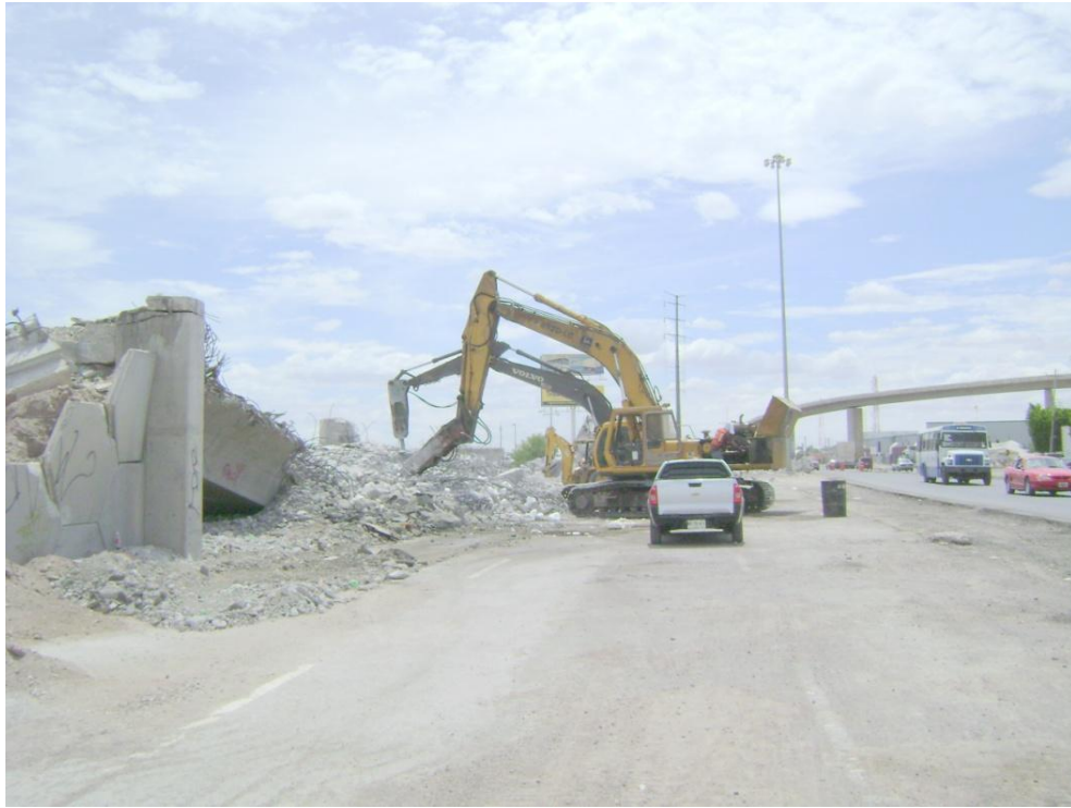
Figura 85 Demolición de viaductos y estribos con martillo en posición más cómoda.
