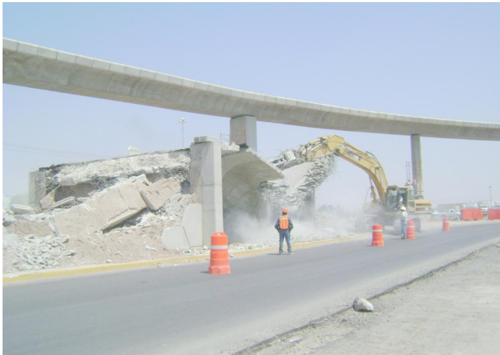
Figura 82 Corte y demolición total del viaducto de estribo sur.
