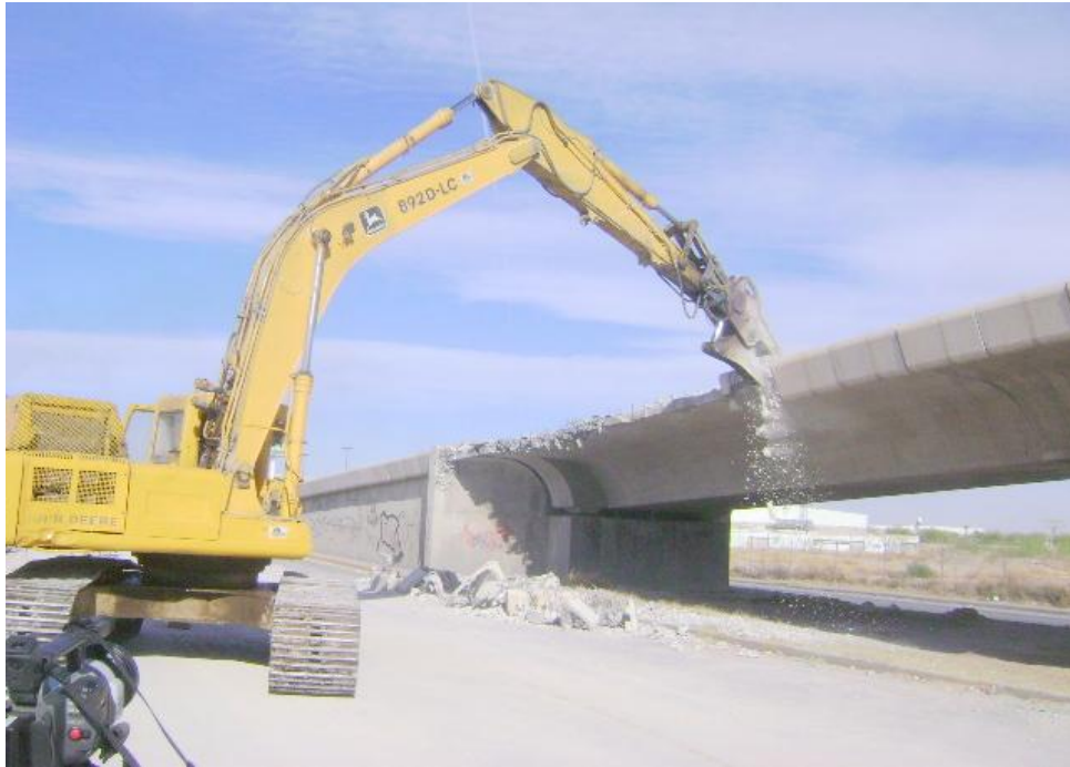
Figura 67 Demolición de ala exterior del tramo de estribo norte.
