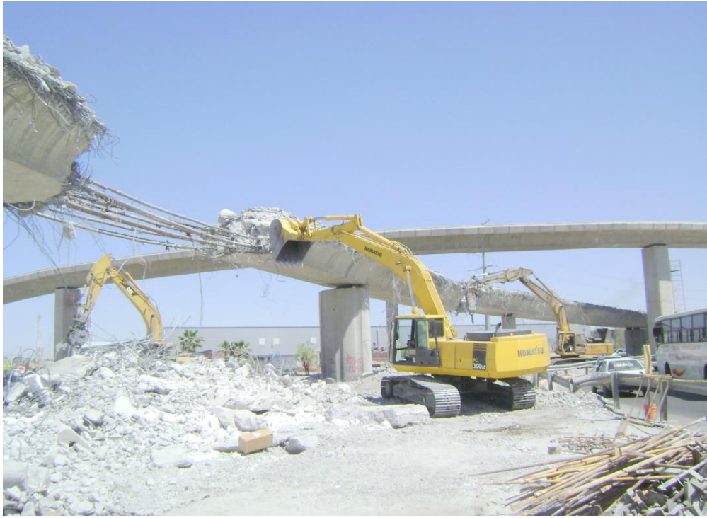
Figura 75 Demolición y corte de ambas secciones laterales del viaducto secundario de mayor claro.
