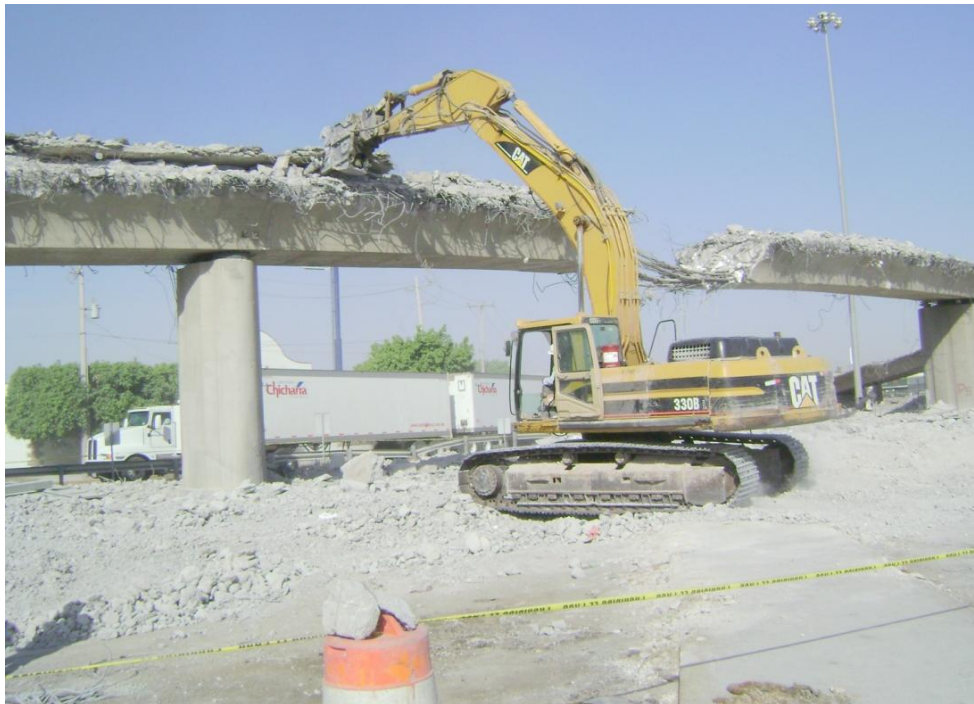
Figura 70 Demolición y corte total del viaducto central primario, en cantiléver.
