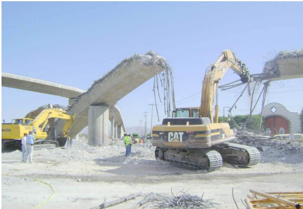
Figura 76 Corte y demolición total del viaducto secundario de mayor claro.
