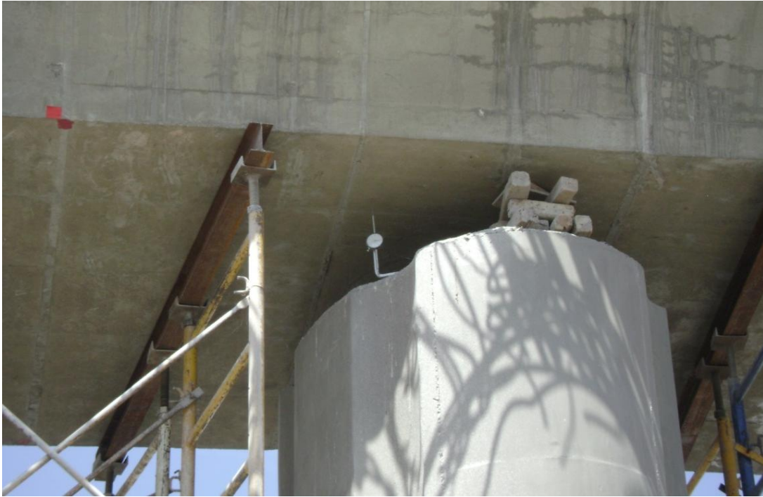
Figura 50 Etapa de instrumentación (colocación de micrómetros y medición de grietas).
