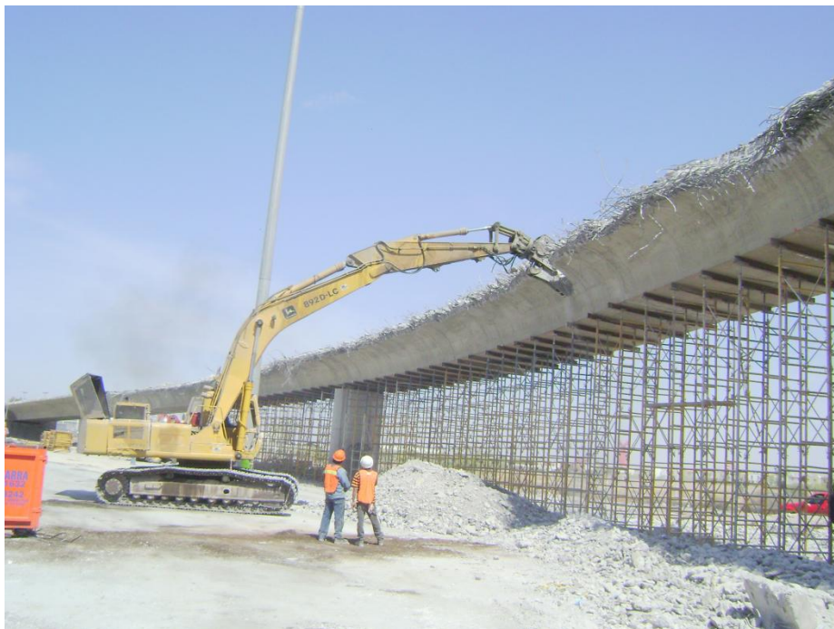
Figura 64 Demolición de ala interior del tramo terciario.
