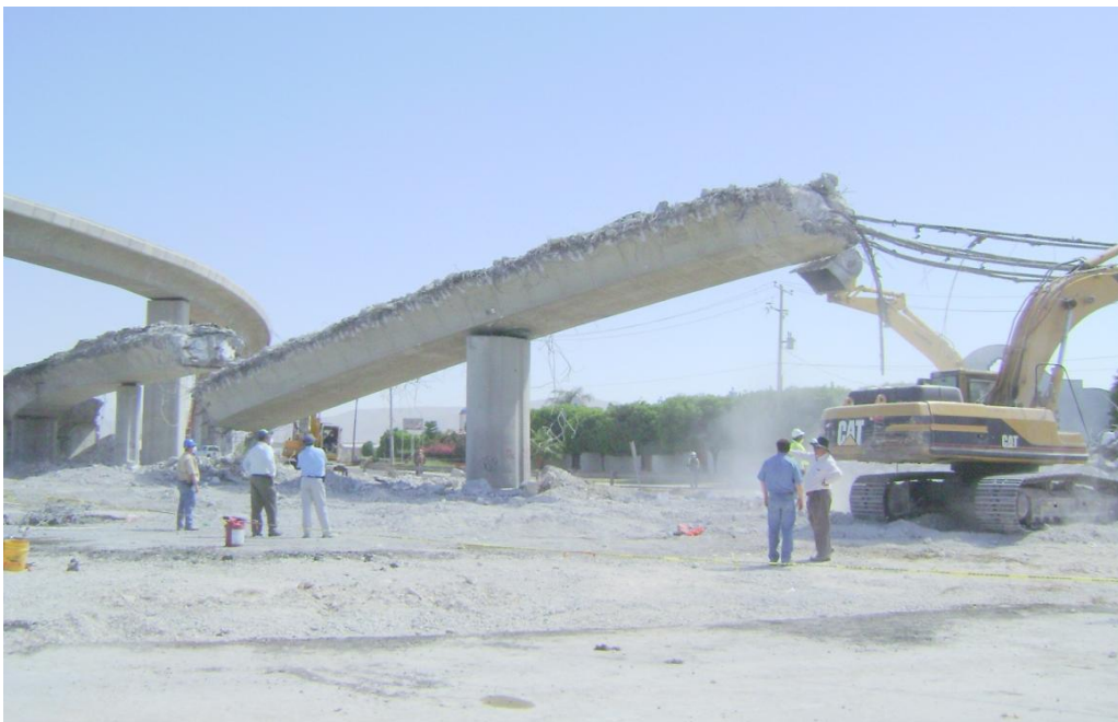
Figura 72 Corte y demolición total del viaducto central de mayor claro.
