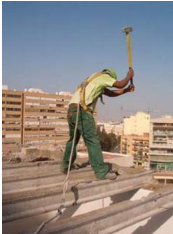
Figura 1 Demolición manual empleando mazo mediano.
