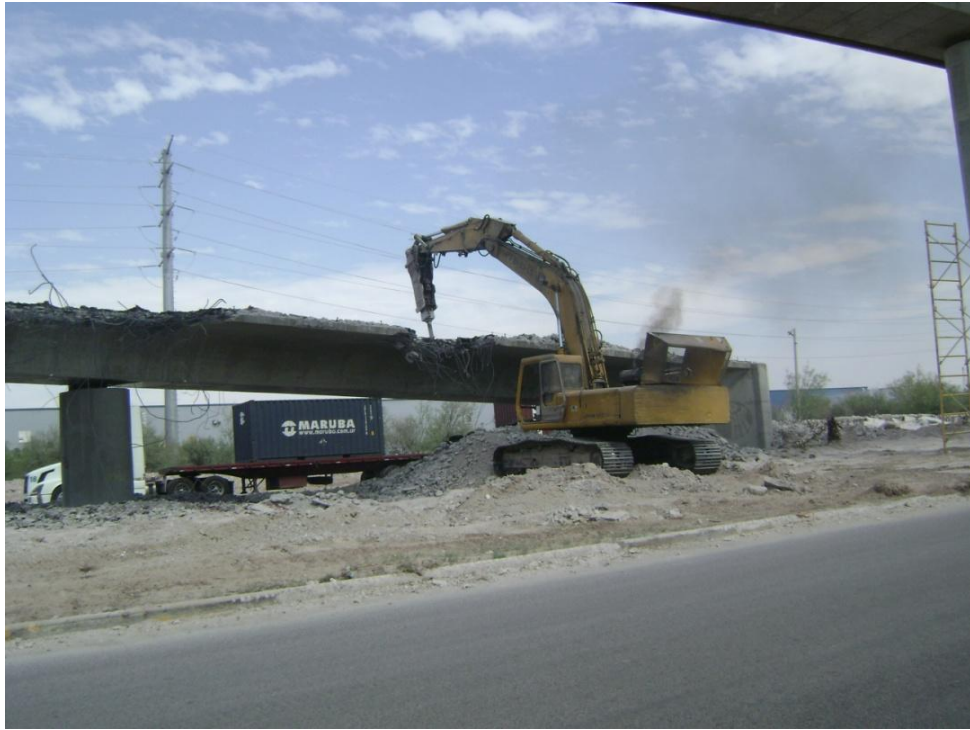
Figura 81 Demolición y corte de ambas secciones laterales del viaducto de estribo sur.
