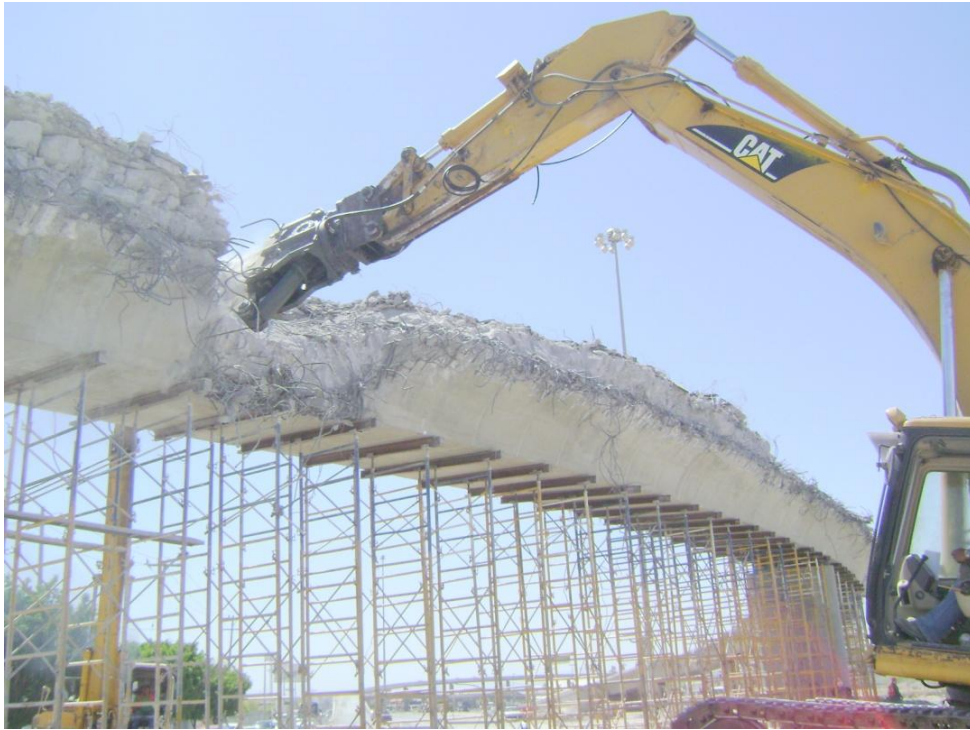
Figura 79 Demolición y corte de ambas secciones laterales del viaducto terciario.
