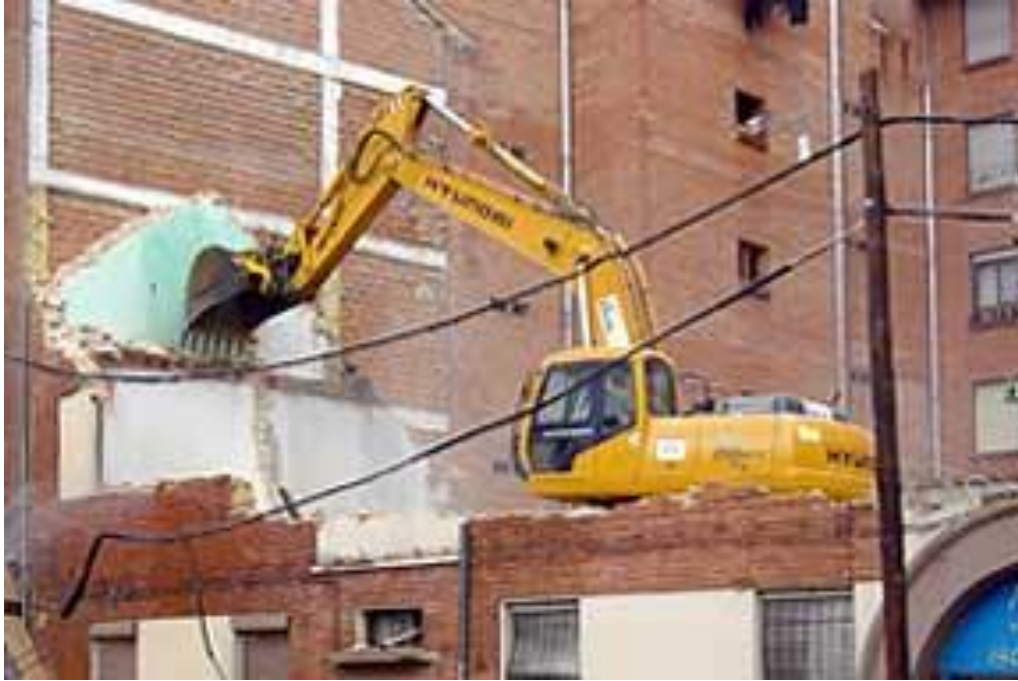
Figura 3 Operación de maquina en demolición.
