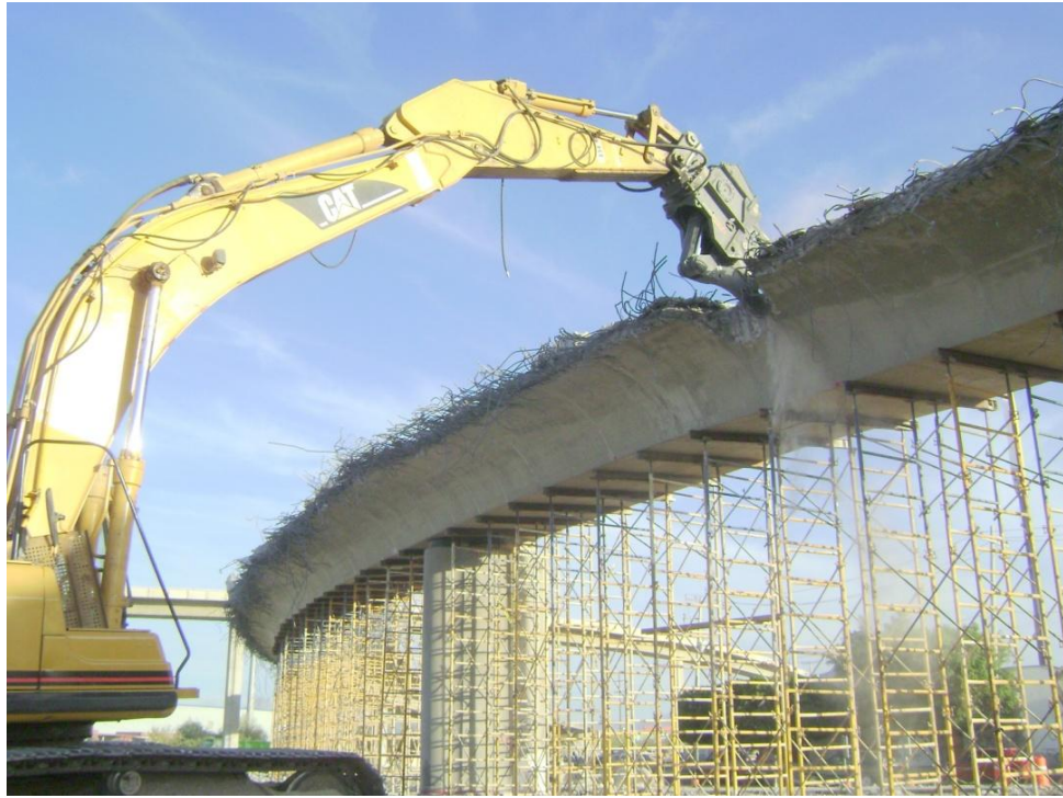
Figura 69 Demolición y corte total del viaducto central primario.
