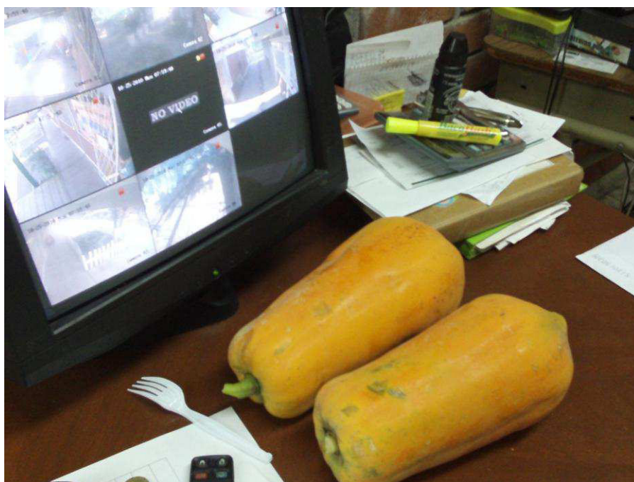
Figura 29. Monitor de cámaras de seguridad.
