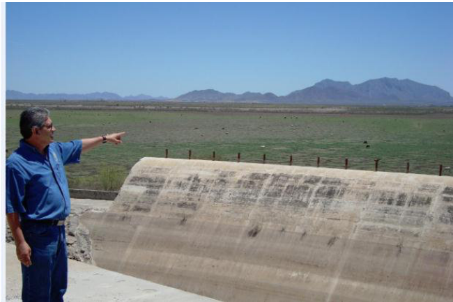
Fig. 3.13 Vista del vertedor y el vaso de la presa ALR Fuente: foto de origen propio
