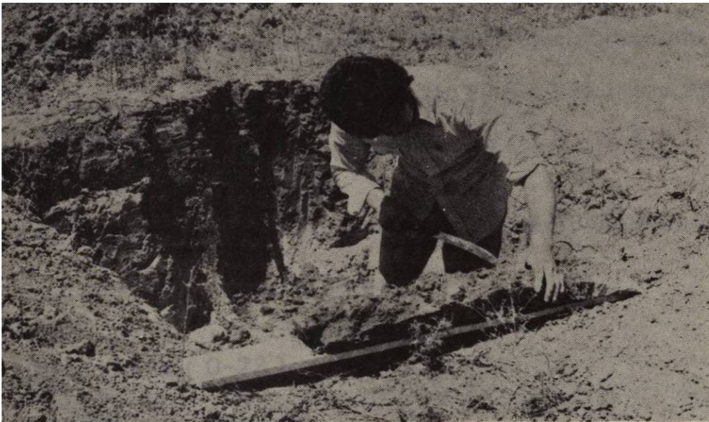
Figura N° 21 . Acabado de Monolito.
