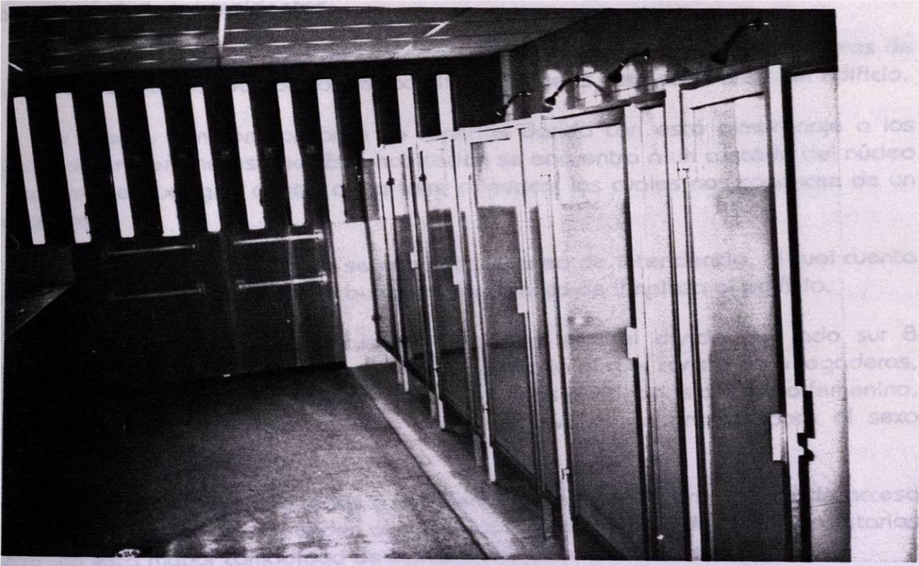
REGADERAS, EN BAÑOS DE MUJERES.
