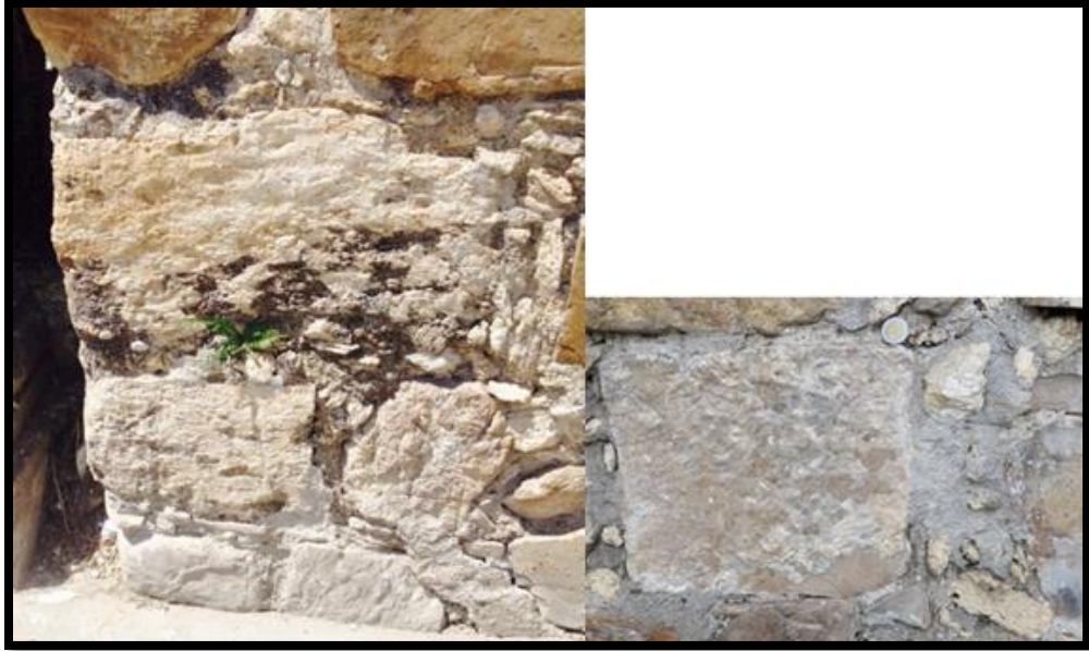
Figura 34 El caliche presenta un color amarillo fuerte en sus bordes, señal de intemperismo alto, la mayoría de los sillares que se colocan en la parte del suelo se comportan como una tela, al momento en que llueve estos absorben el agua por capilaridad de abajo hacia arriba, son rocas que persisten menos al desgaste. Al lado derecho se puede observar una arenisca cubierta casi en su totalidad de una pátina en color blanca que corresponde a la cristalización de sales.
