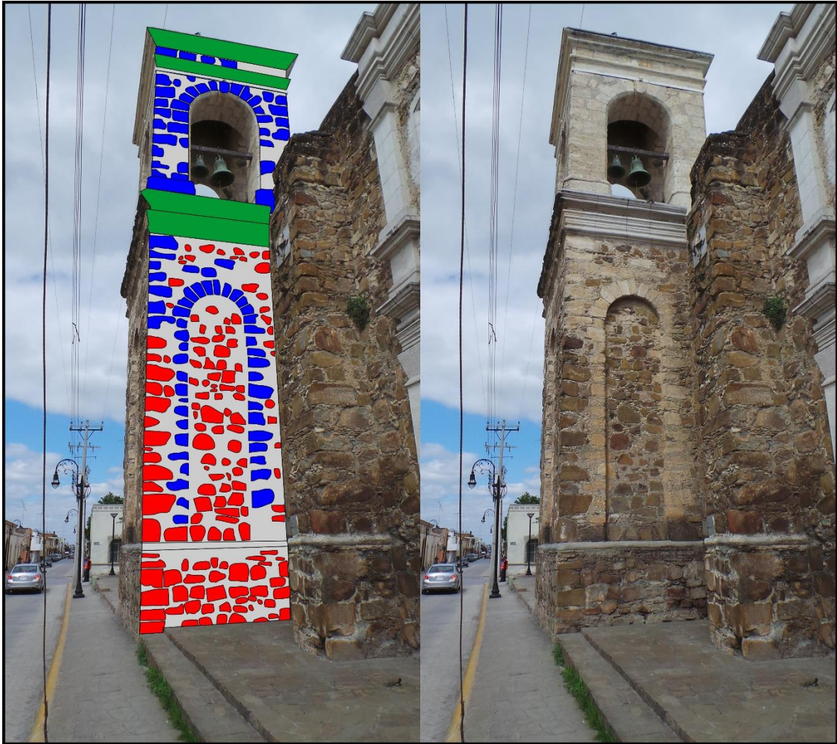
Figura 18 Parte sur del campanario, presenta la misma forma que en la parte frontal y oriental. Las areniscas componen la mayor parte de la estructura, seguido del travertino, travertino trabajado y al final el mortero.
