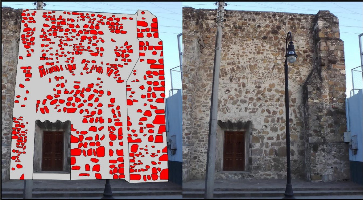
Figura 20 Segunda parte de la fachada oriental, constituida principalmente por areniscas y mortero, contiene una gran cantidad de mortero, que se puede apreciar en la parte superior de la puerta, esto debido a las restauraciones recientes que se llevaron a cabo en la construcción. También resalta un tercer contrafuerte al lado derecho de la imagen, constituido por areniscas.
