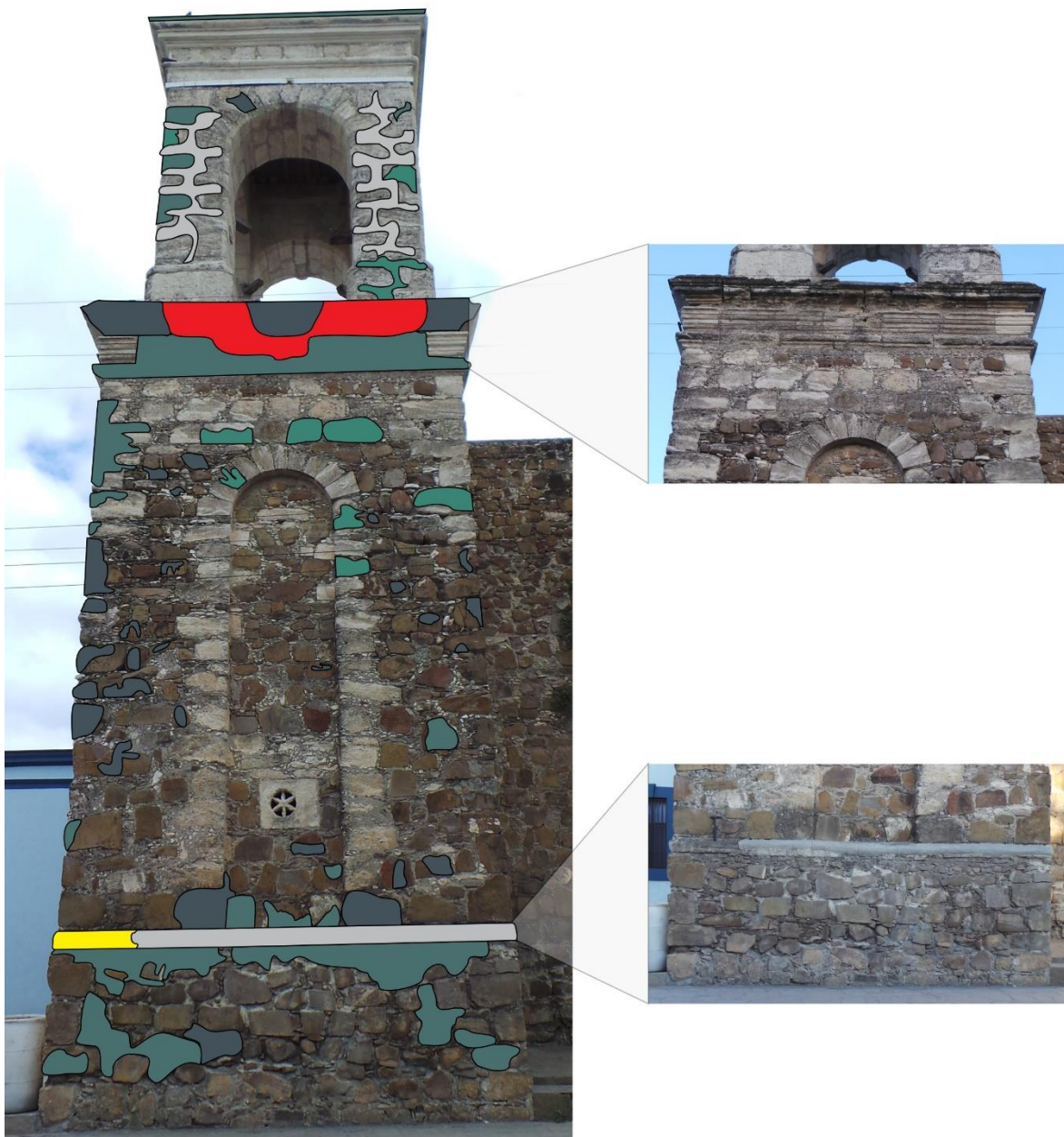
Figura 38 En diferentes tonalidades de verde se observan los daños por decoloración que afectan la mayor parte del campanario, las tonalidades más oscuras representan un daño más marcado. En color amarillo se observa la pérdida de material por erosión en uno de los moldes, seguido de un color gris que representa daño por remodelación en dónde fue utilizado mortero hecho a base de cemento portland y no de travertino. En la parte superior en color rojo la separación de material por agrietamiento, a la par de una fuerte decoloración en el travertino.
